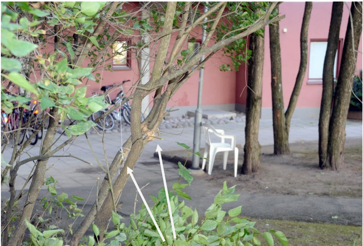
Bild 15 Två gula sonder som påvisar linjerande skador. Se Bild 16.
