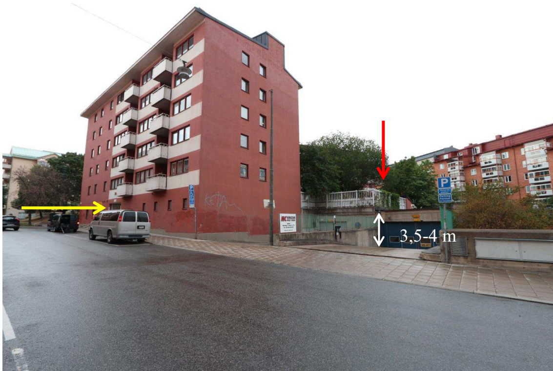
Bild 7: Norrbackagatan 41-43 fotograferat från Norrbackagatan med ingång/passage markerad med gul pil. Till höger i bild ses nedfarten till ett garage vars tak används som innergårdens terrass (Röd pil). Vit pil visar höjd mellan terrass och nedfart.
