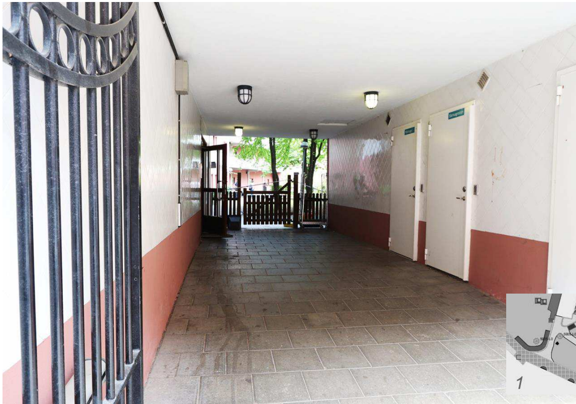
Bild 8: Passage från Norrbackagatan. Till vänster ses dörren till trapphuset Norrbackag. 41 och rätt fram, ett trästaket med grind som skiljer innergården från passagen.
