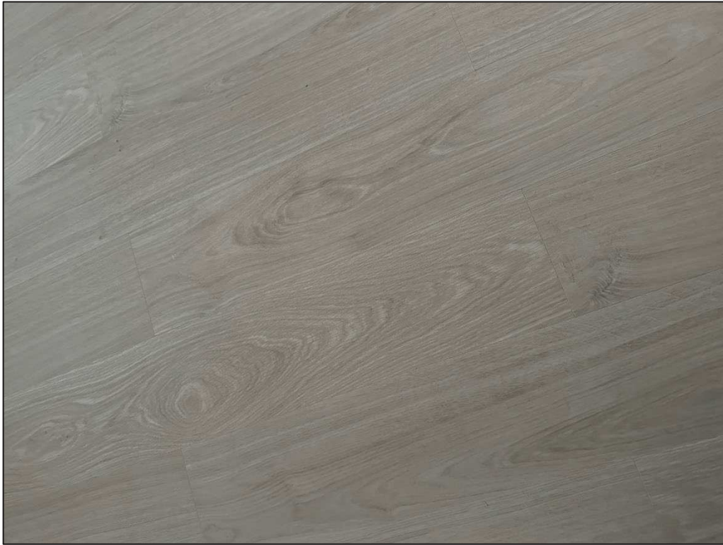
Bild på golv på Slagstavägen 115
