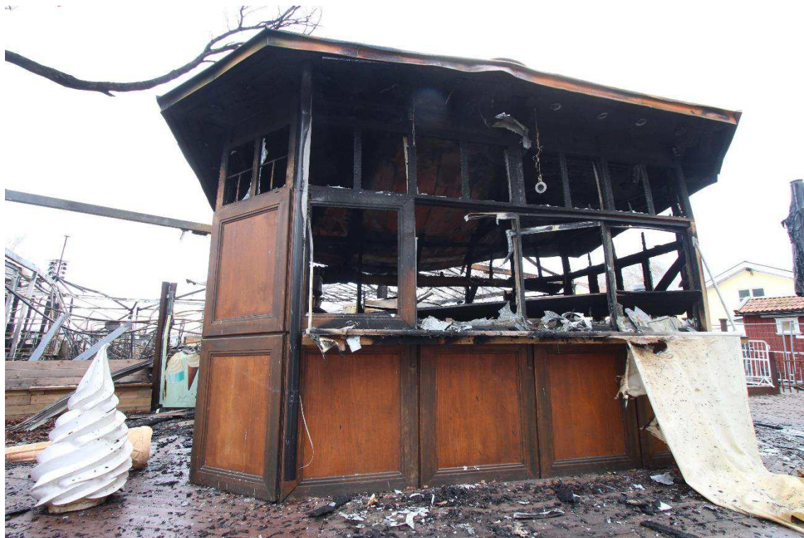
Figur 11. Träbyggnaden sedd från Galärvarvsvägen.
