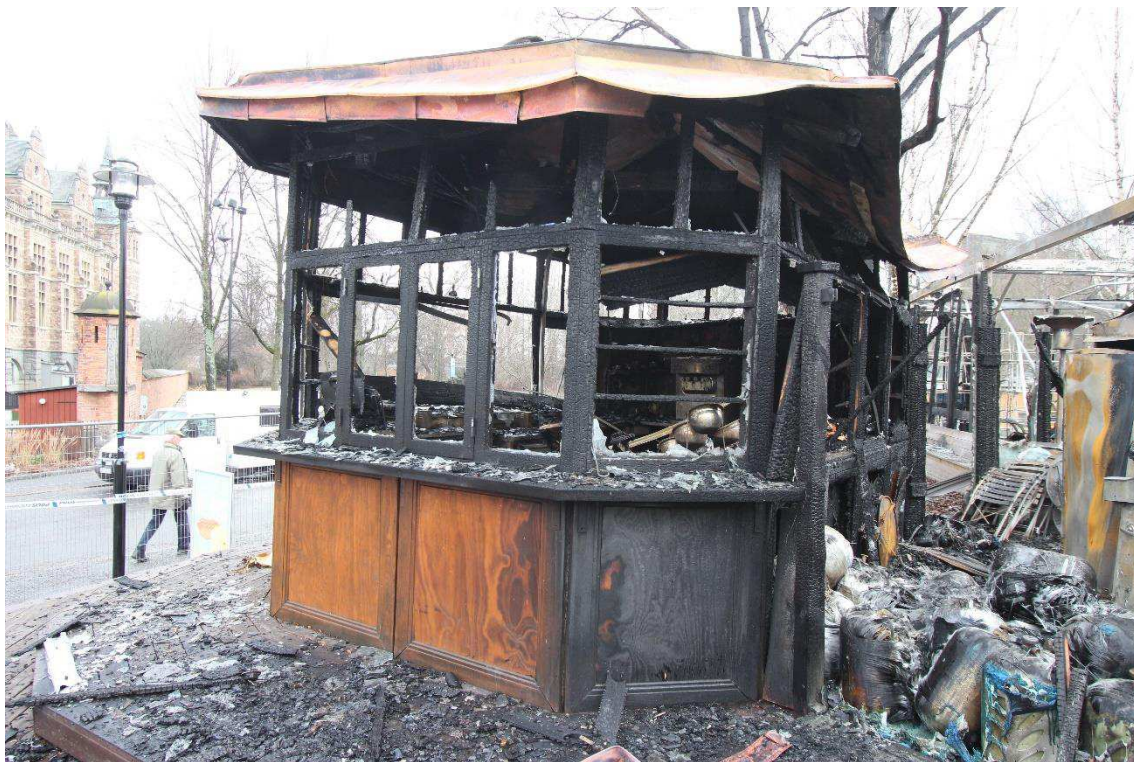
Figur 10. Träbyggnadens sida mot paviljongdelen till höger i bild.
