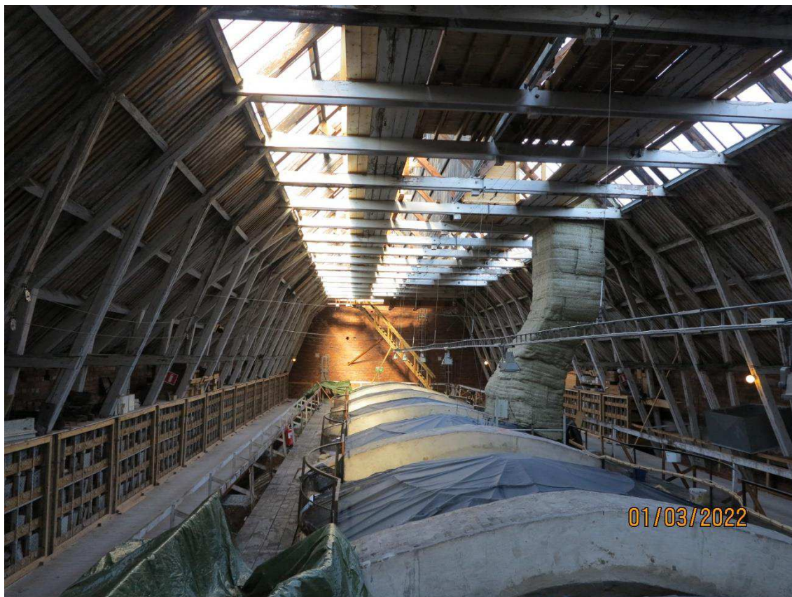
Figur 4. Bilden visar museets vind. Bärverket är i trä och delar av taket är i glas. Foto: Åke Westman, 2022-03-01.
