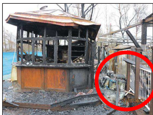
Figur 1. Visar baren som är placerad närmast Nordiska museet och avståndet är ca: 20 m. Strålningsvärmen från den brinnande baren och gasolflaskorna hotade den intilliggande träbyggnaden, men även miljön runt branden som var en farlig miljö för människor att vistas i. (se bild ovan) Röd cirkel visar gasolflaskorna (40). Foto: Åke Westman, 2022-02-17.
