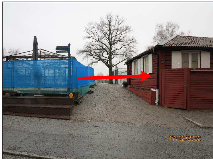
Figur 1. Avståndet mellan den brinnande delen och närmaste byggnad är 4 m. Stor risk för brandspridning. Notera fönstren som vetter mot den brandutsatta delen. Foto: Åke Westman, 2022-02-17.
