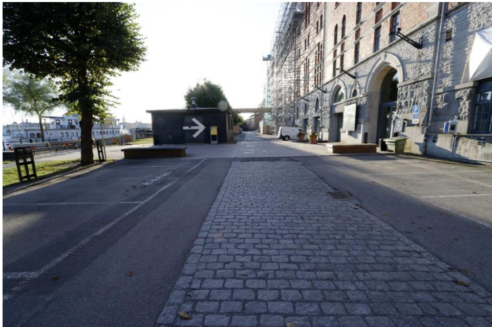
Förrådsbyggnadens högra kortsida.
