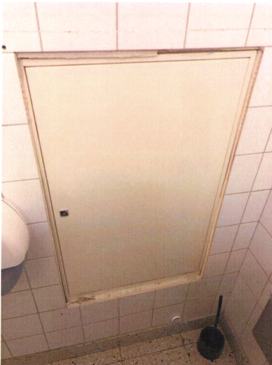
Bakomliggande plåtskåp med nycklar synliga nere i bild.
