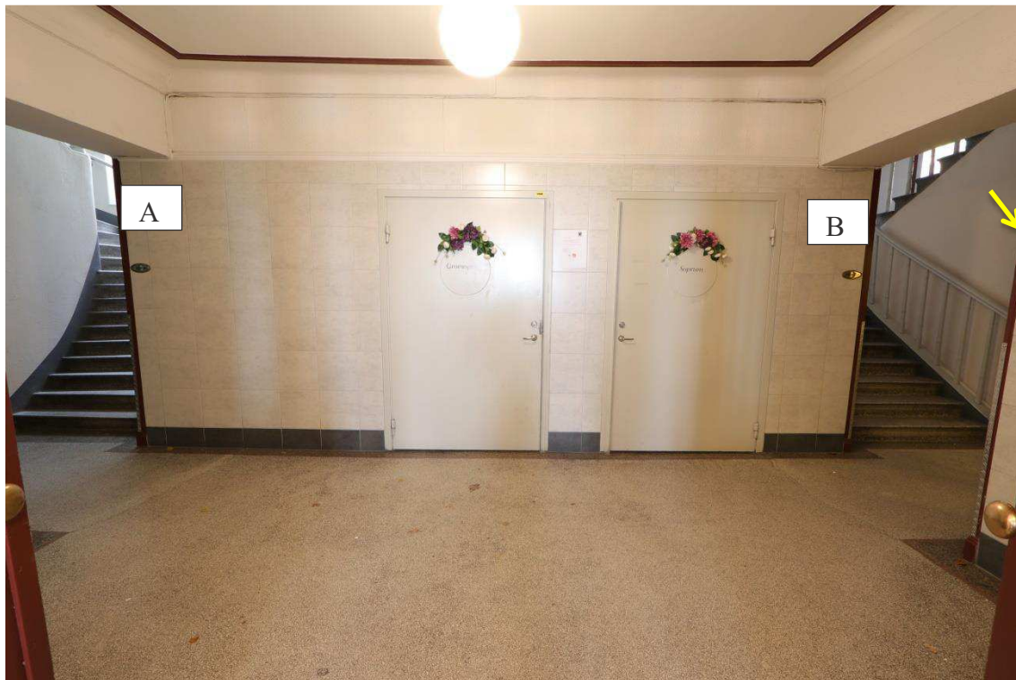
Figur 3. Trapphuset till Norrtullsgatan 65A, B, Stockholm. Pilen markerar nergången till tvättstugan.
