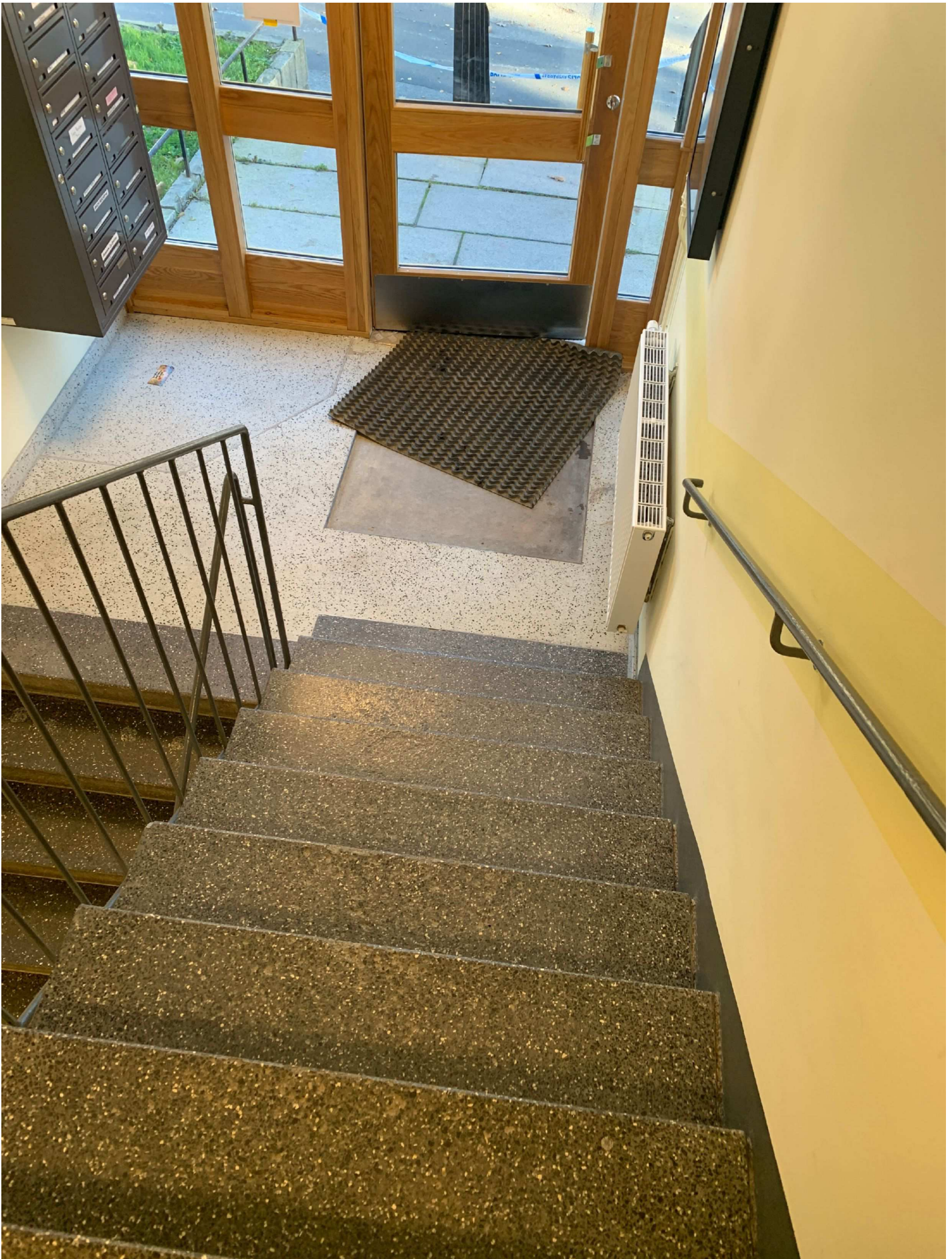
5. Mercuriusvägen 1 - halvtrappan från vån 1 till bottenvåning
