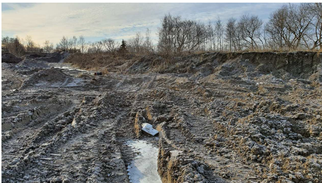
Figur 2. Tilltänkta massor för eventuell sluttäckning av deponi i Laxå kommun. Foto: MD Miljökonsult AB 2020-02-05.
