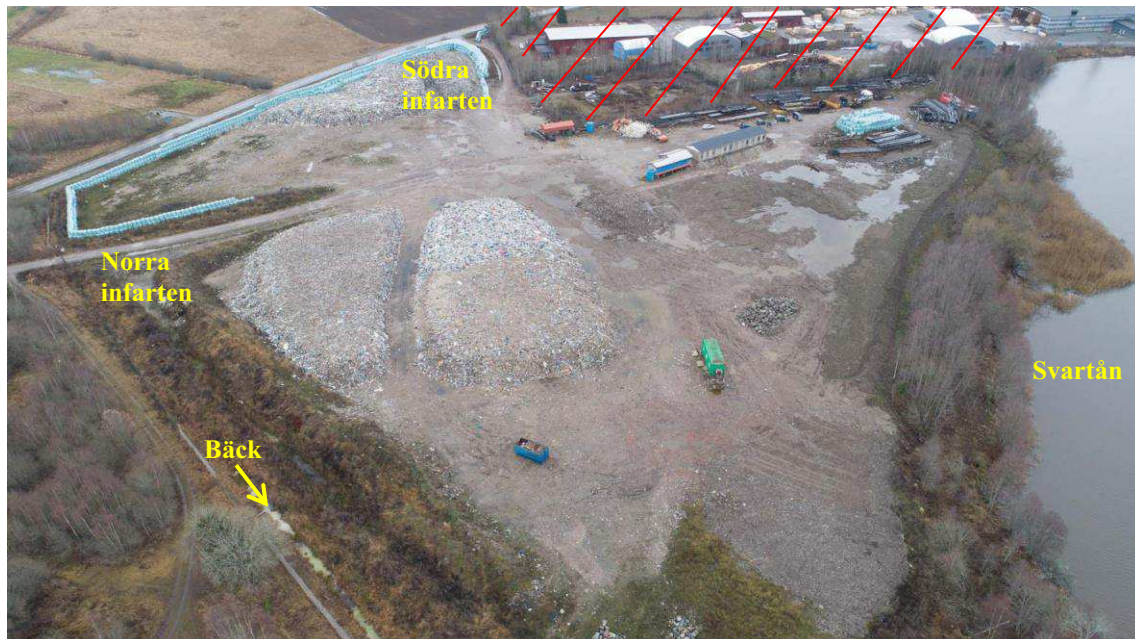
Figur 5. Översiktsbild över fastigheten fotograferad i sydostlig riktning.
