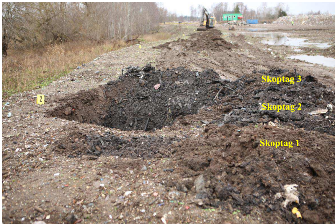
Figur 14. Exempel på den systematik som användes vid grävningen.
