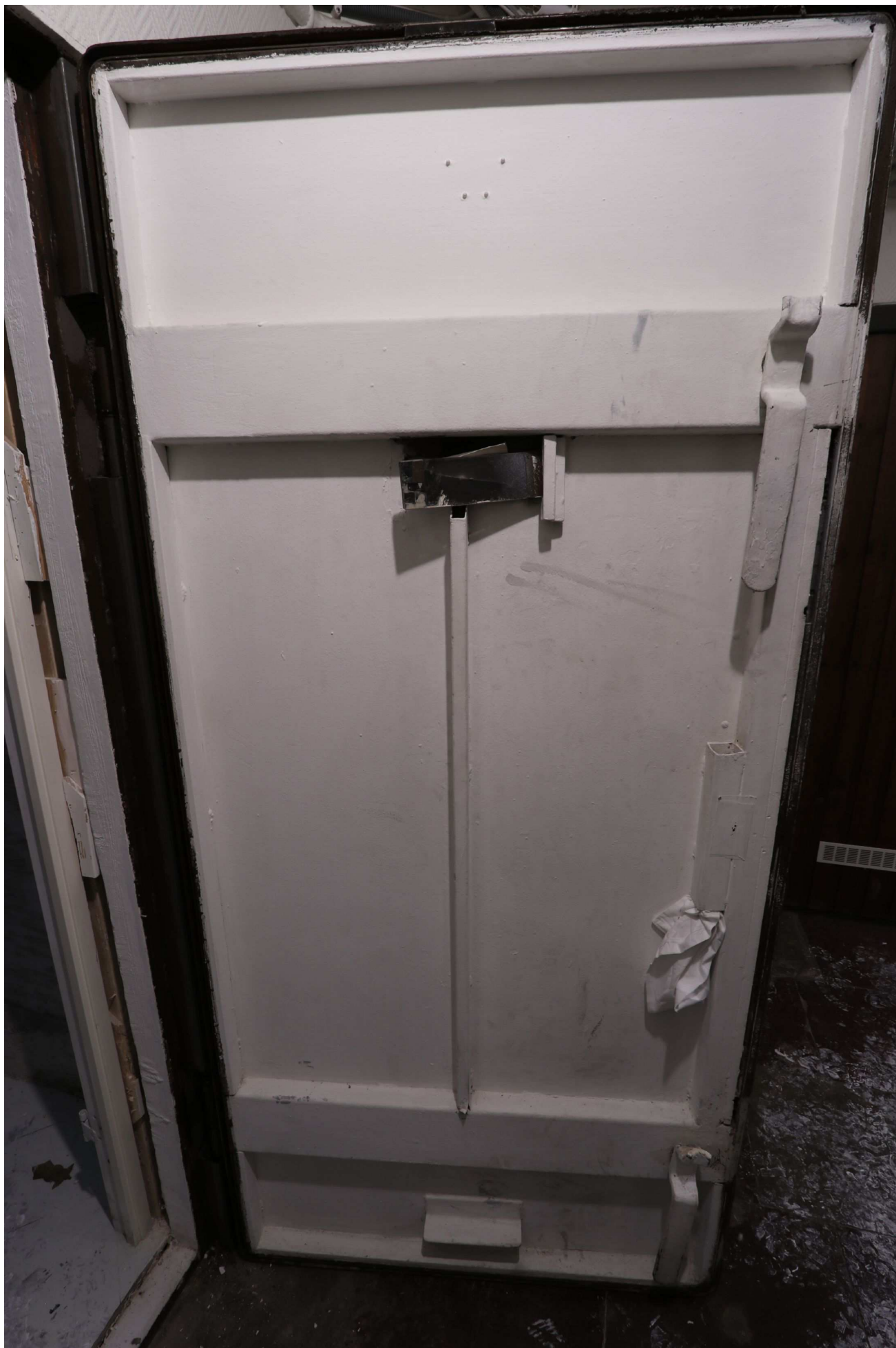
3. Insidan av ståldörren nedanför trappan som leder in till studion.
