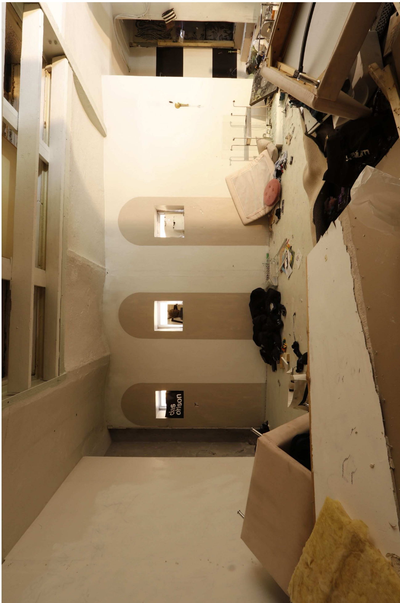
14. Bild tagen så att den vita uppsatta väggen är till vänster i bild. Fönstren rakt fram. Ingången/trappstegen till höger i bild.
