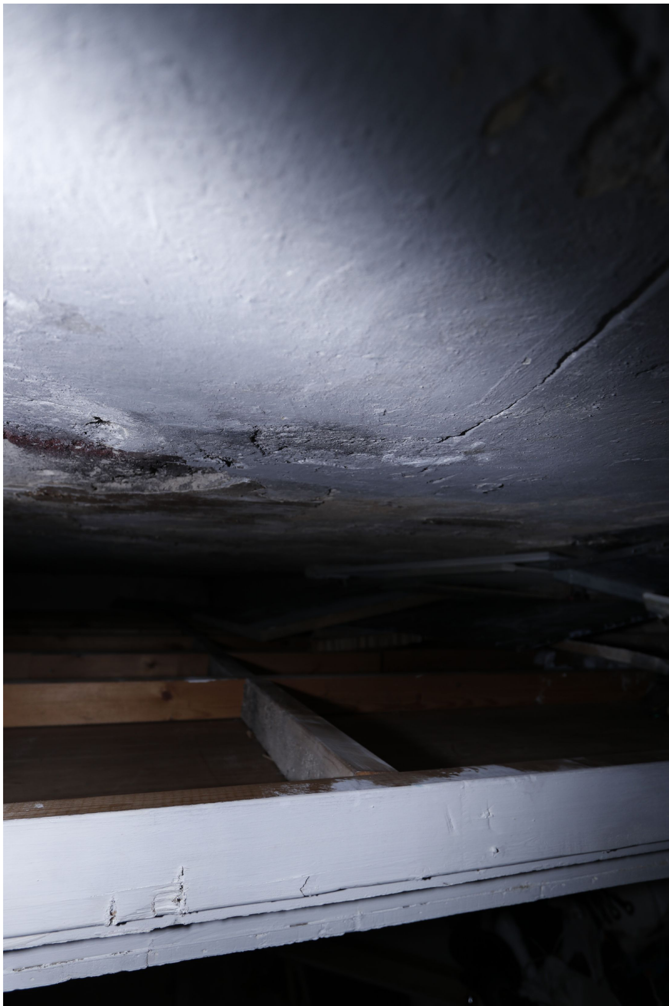
15. Bild tagen innanför den vita uppsatta väggen. Ca 30-40 cm mellan väggarna.
