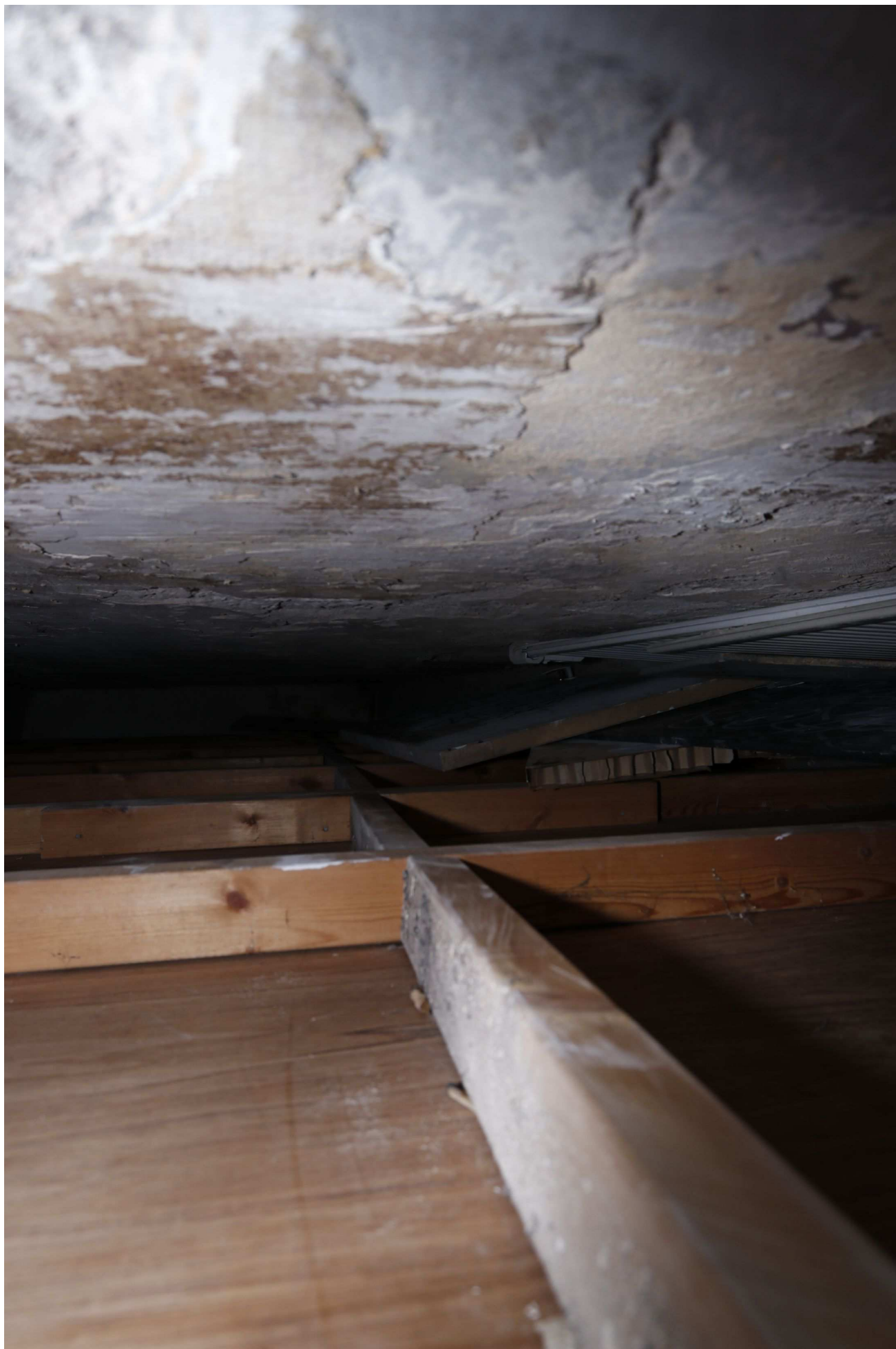
16. Väggen som är uppsatt i studion längs med ena väggen.
