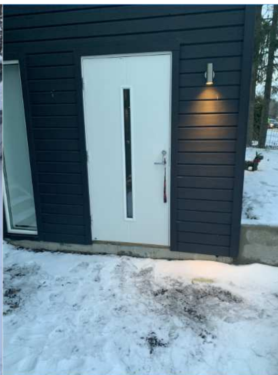
Entredörren till Attefallsbyggnaden.
