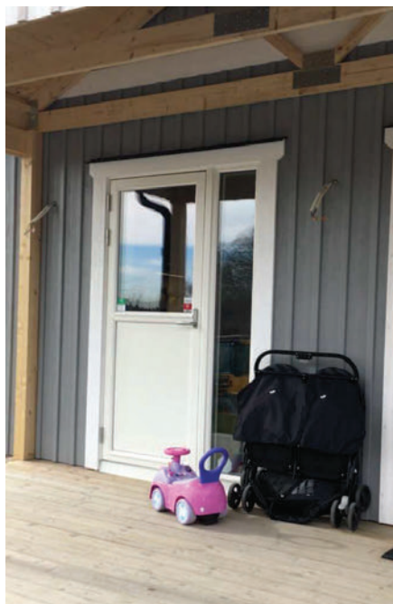
Bild 11-12: Ej färdigmålad fasad och ej färdiga elarbeten, husets entrésida.
