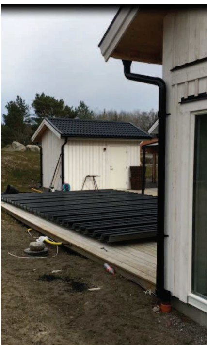
Bild 17: Ej färdigmålad förrådsbyggnad, i förgrunden den ej färdigställda poolen.
