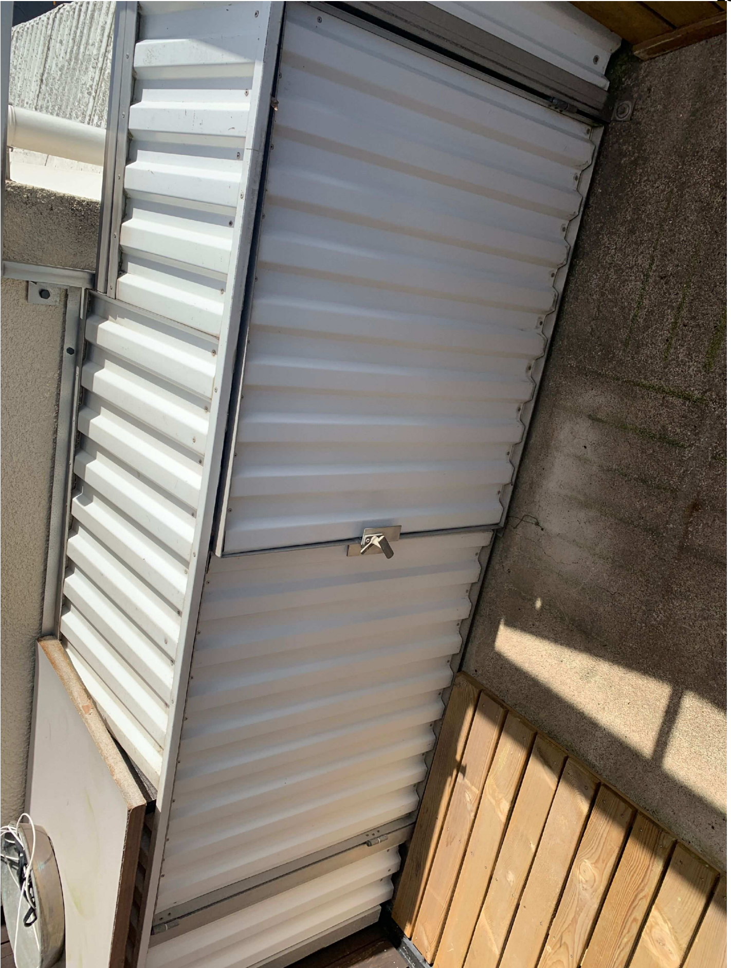
2. Plåtskjul på balkongen, två trallpartier har plockats undan framför för att kunna öppna det.
