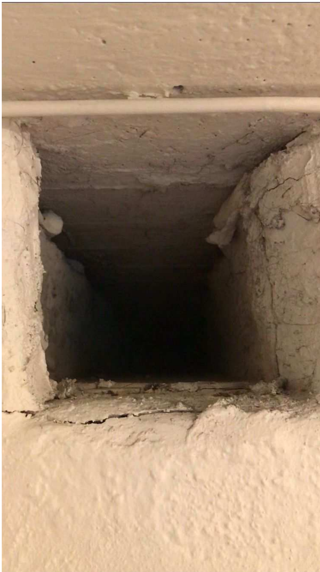
4. Utrymme i cykelrum precis under taket.
