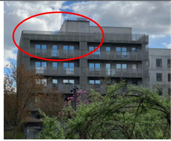
Jämförelsebild tagen av polis av husfasaden till Bobergsgatan 59 B, bild tagen 2025-04-29.
