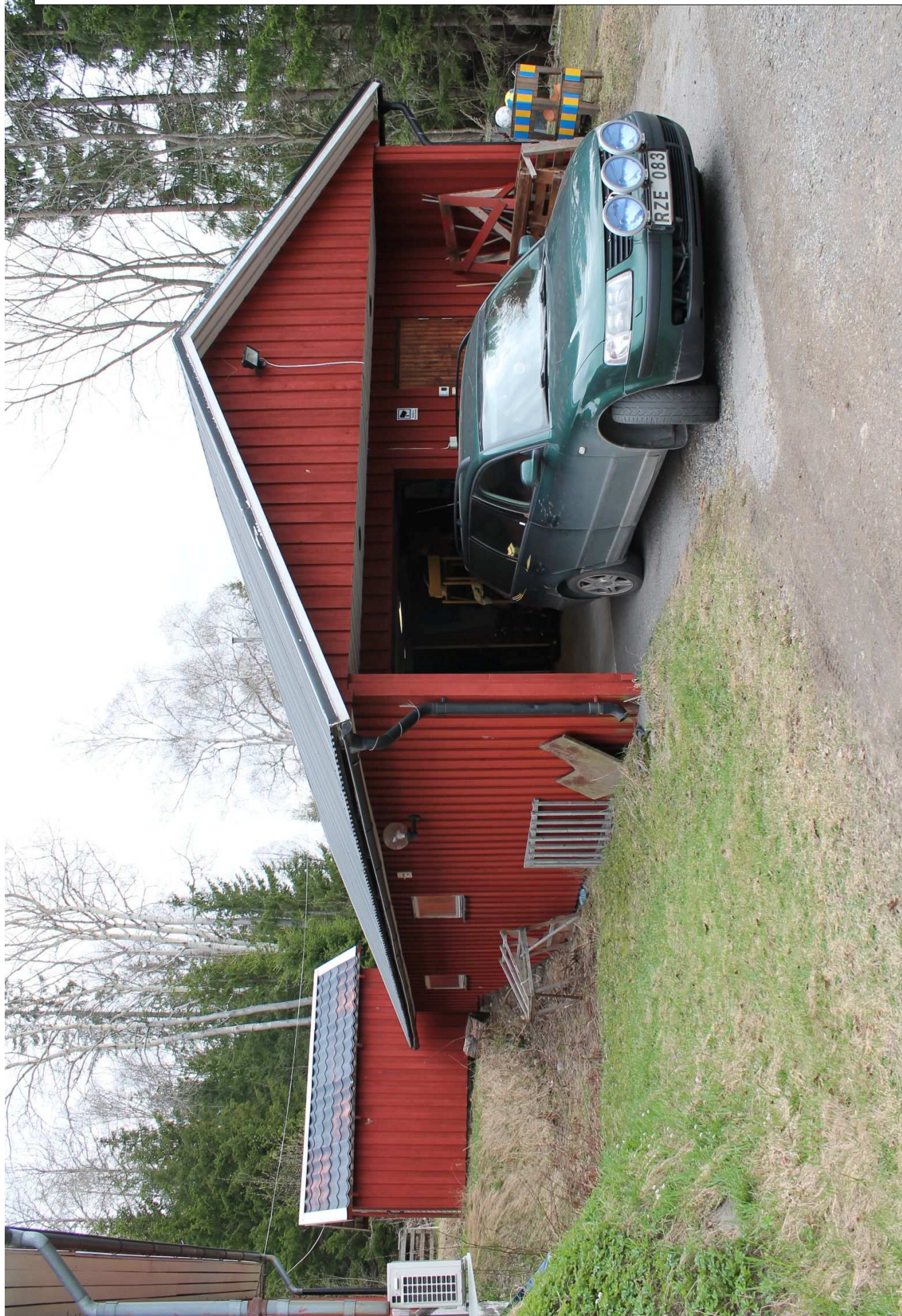
Översikt utsida garage
