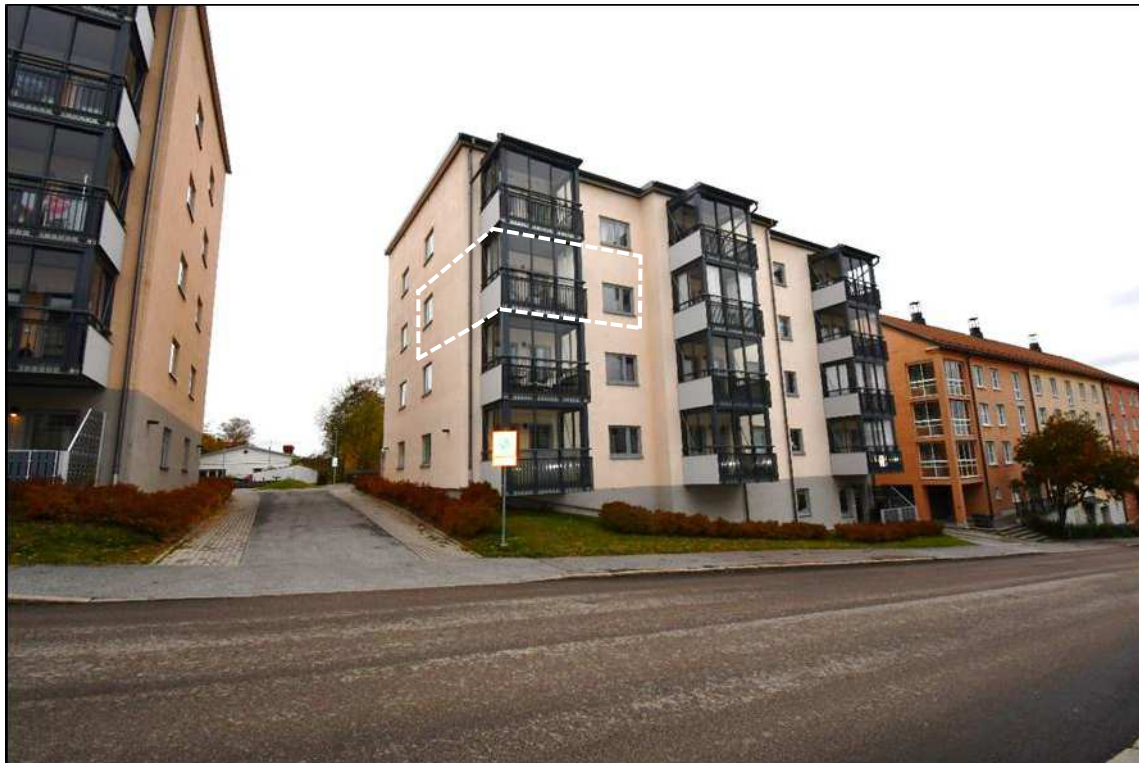
Figur 4. Baksidan till Skolhusallén 18. Markeringen visar den aktuella lägenheten.
