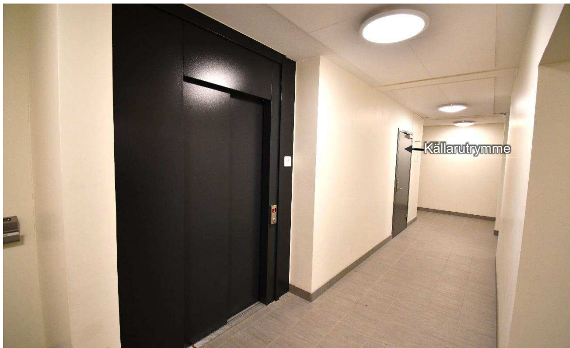
Figur 5. Intill dörren till källarutrymmet med förråden 1–15 finns en hiss.
