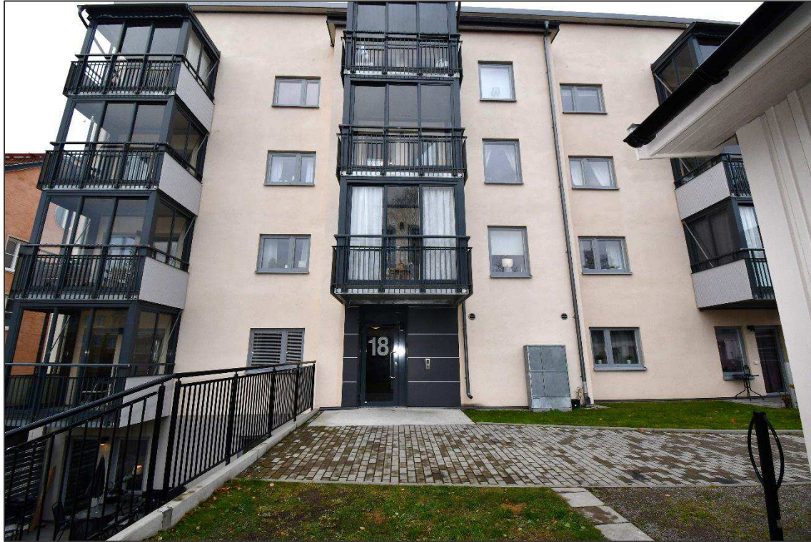
Figur 3. Framsidan samt entrédörren till Skolhusallén 18. Den aktuella lägenheten är placerad på baksidan utav flerbostadshuset.
