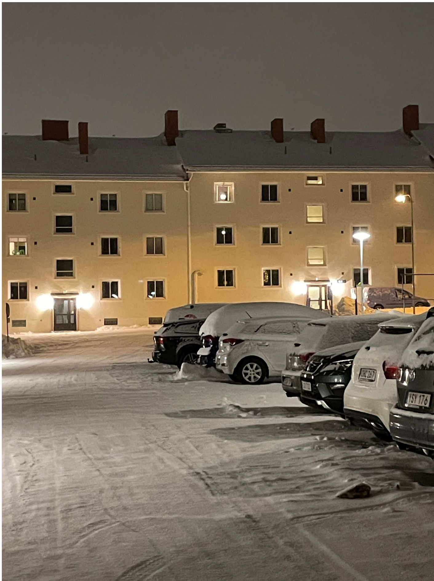
1. Foto över Läraregatan 1. Tält trapphus 1B hela vägen upp till vinden
