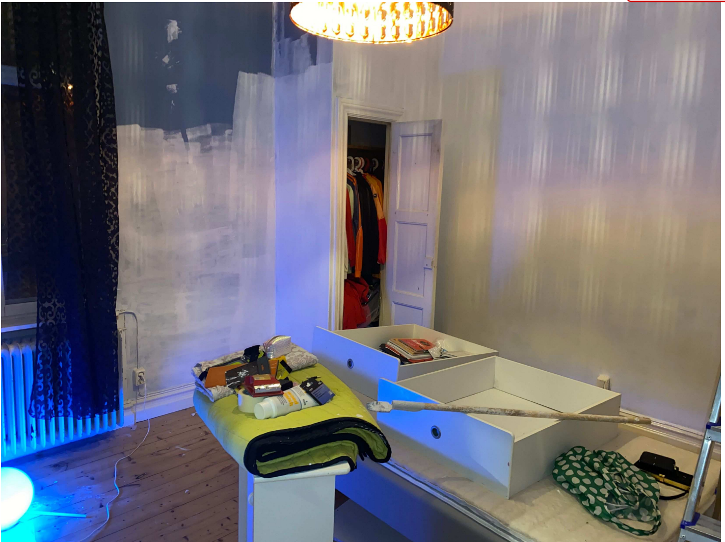
55. Rum pågående renovering. Inbyggd garderob 1/2
