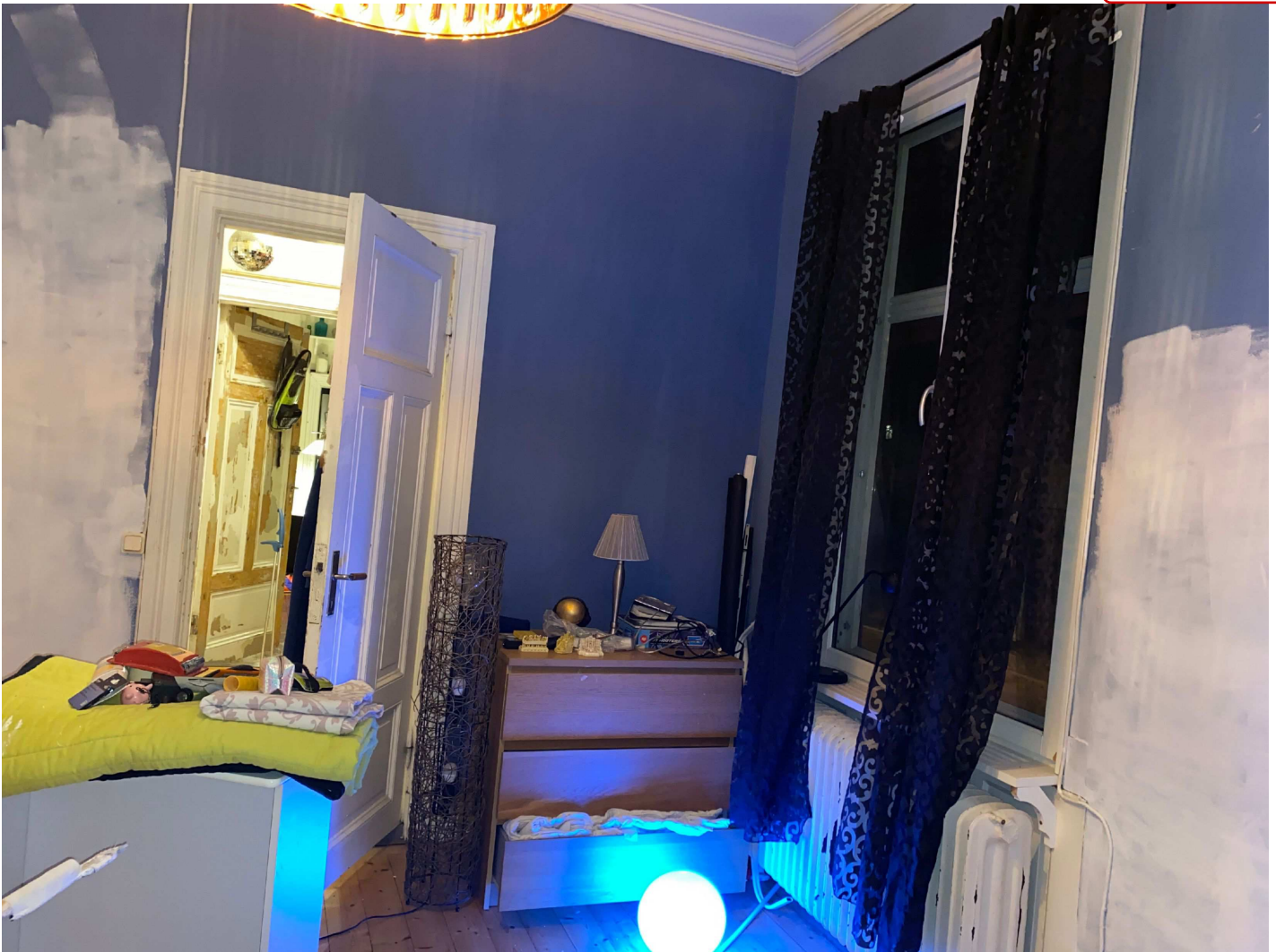
58. Rum pågående renovering
