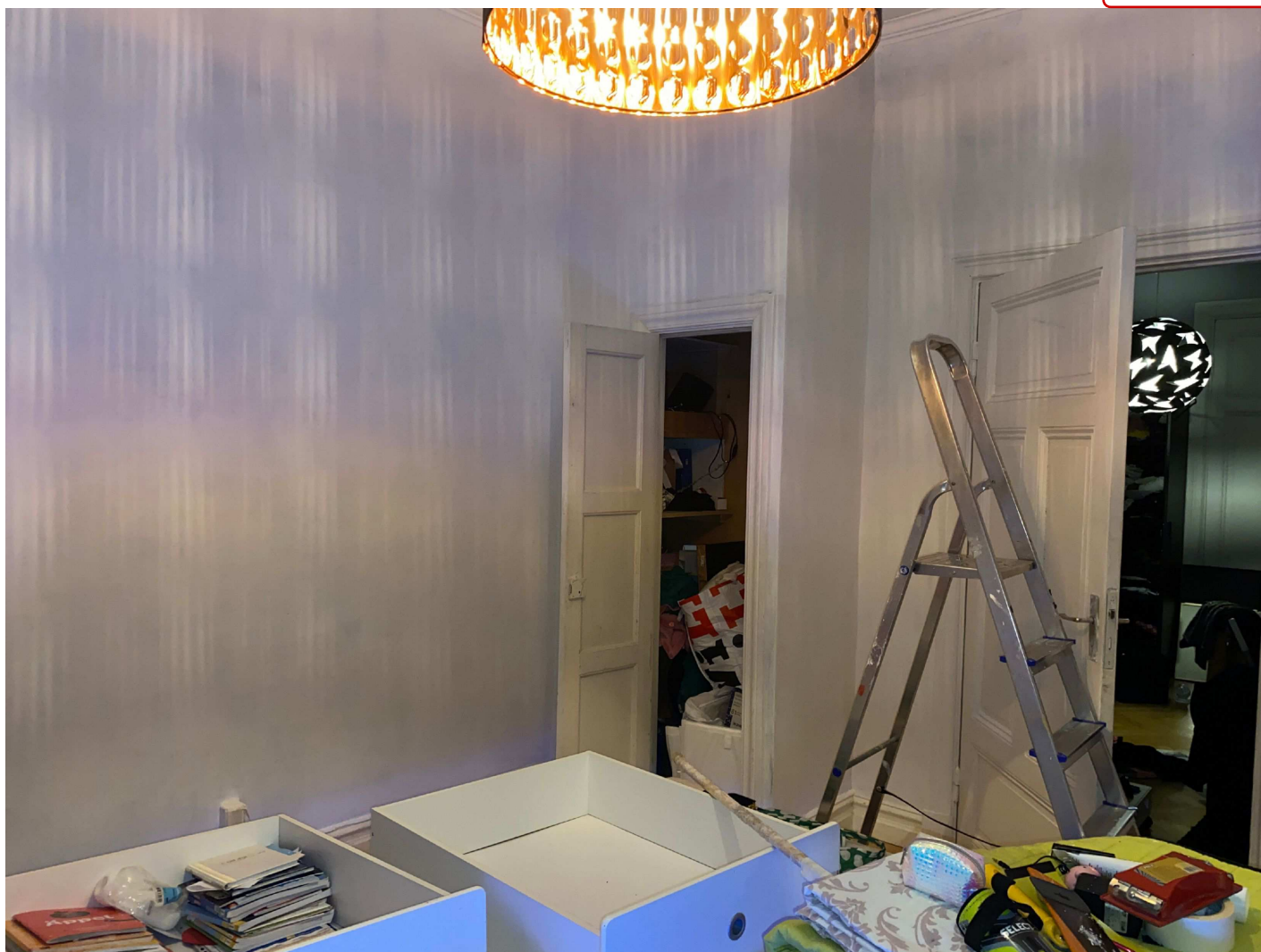
56. Rum pågående renovering. inbyggd garderob 2/2
