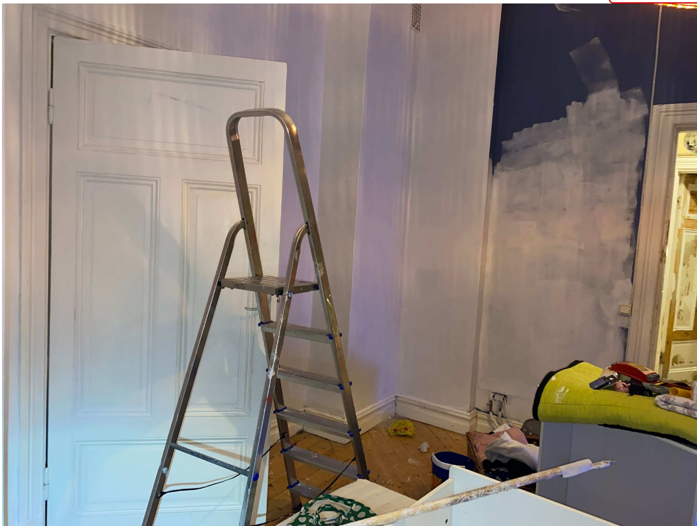
57. Rum pågående renovering
