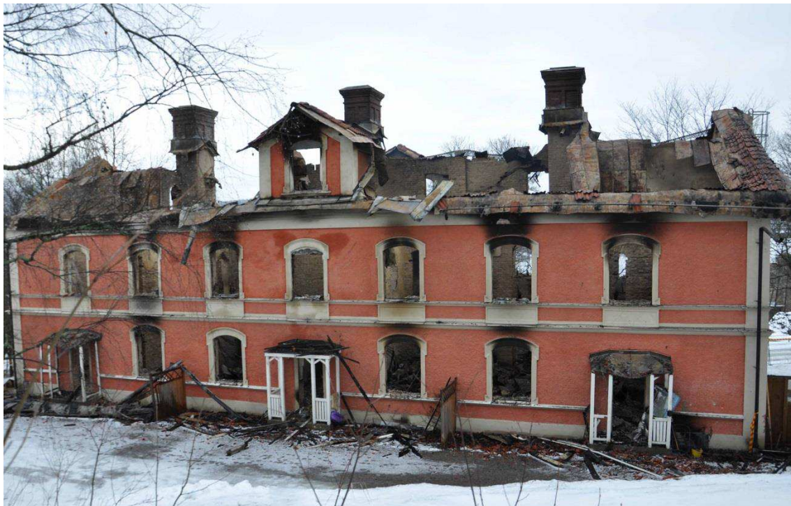
Bild 2. Husets södra sida med tre entrédörrar till ingång 29 A-C.
