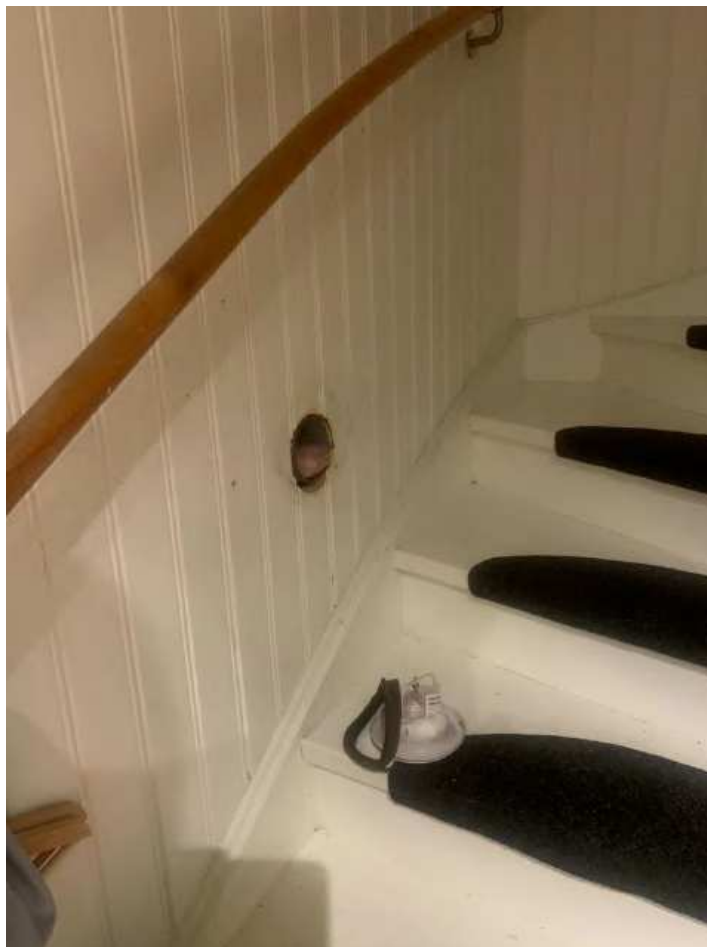
12. Hålet i väggen där redline-påsarna påträffades.
