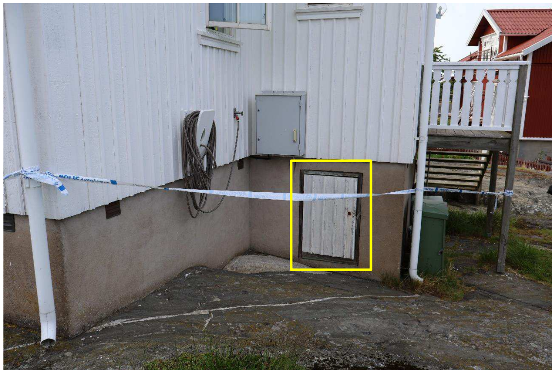
Figur 2. Gul markering visar luckan till kryppgrunden.
