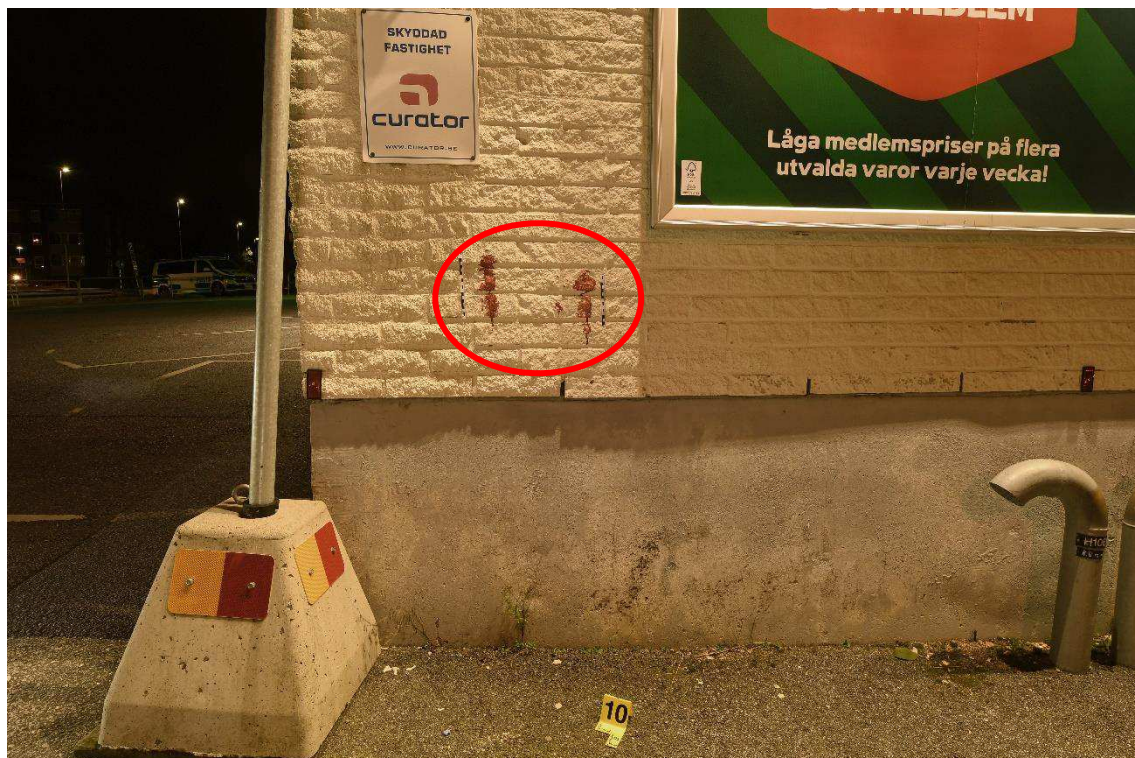
Figur 9. Avsatt blod (S010) på fasaden på baksidan av Coop.
