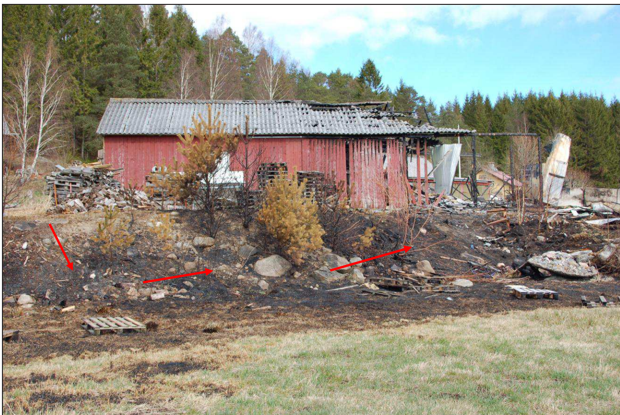
Bild 7. Bild från nedsidan slänten. Elden spred sig ner för slänten och bort mot byggnaden.
