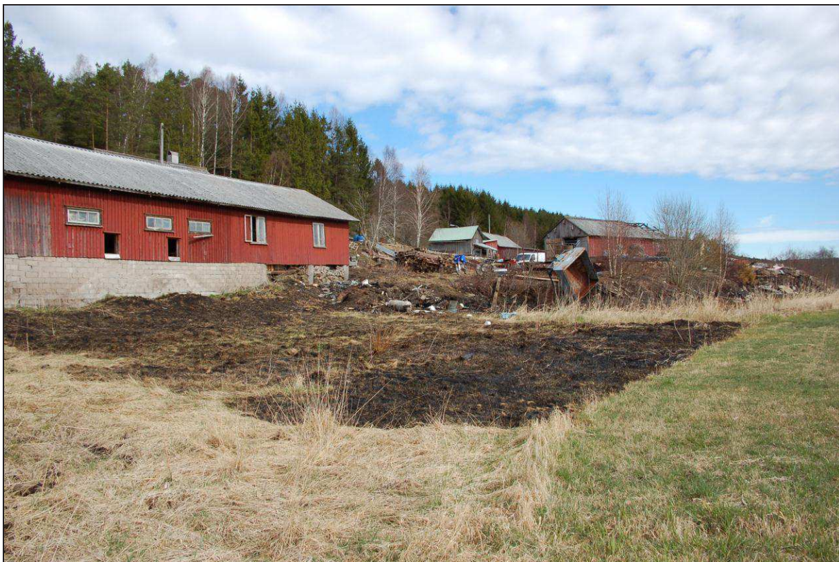
Bild 20. Bränt gräs i kontrollerade former, enligt Zigmas själv. Till vänster om brandskadad byggnad.
