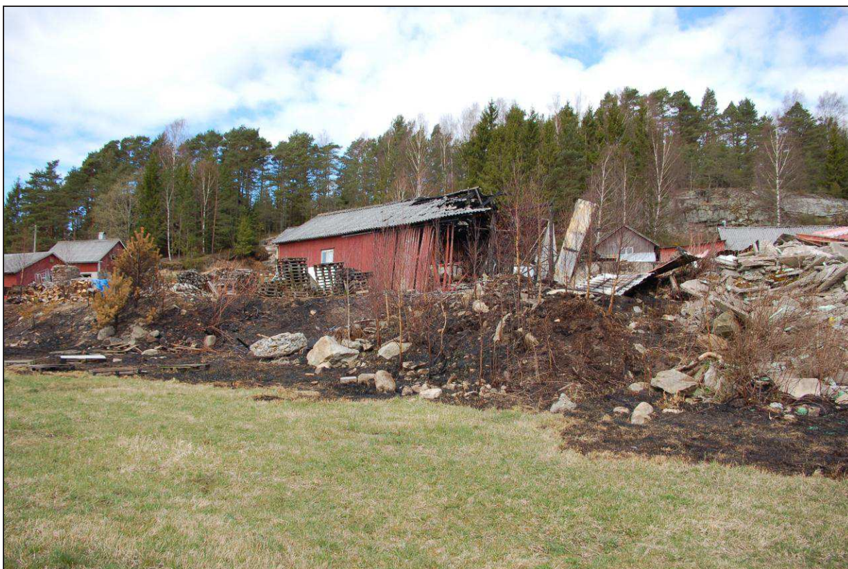
Bild 9. Översiktsbild nedanför brandskadad byggnad.
