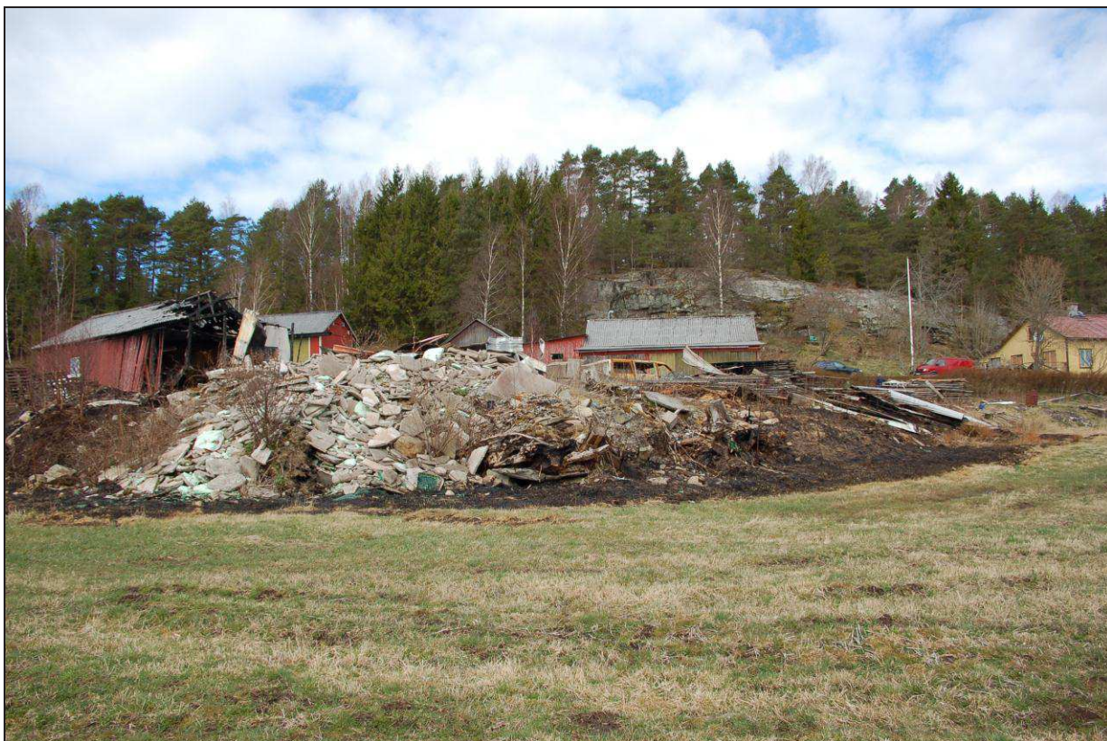
Bild 19. Bild visar bränt gräs längs med hela slänten till höger om brandskadad byggnad..
