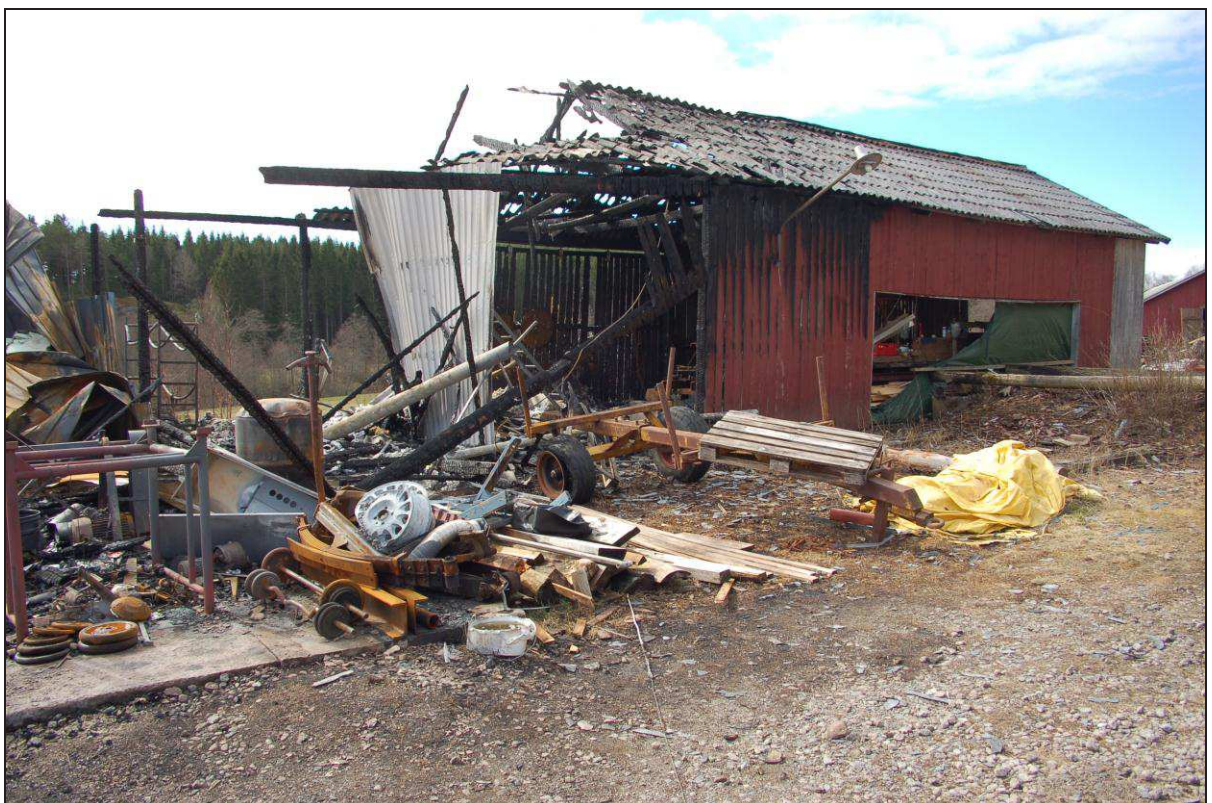
Bild 11. Brandskadad byggnad från andra hållet.
