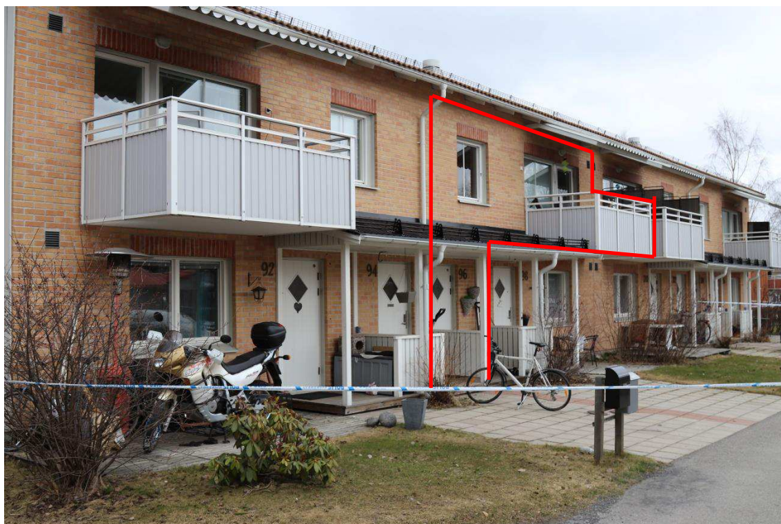
Figur 2. Översiktsbild av bostadshuset. Det röda området markerar adressen Ersbodavägen 96.
