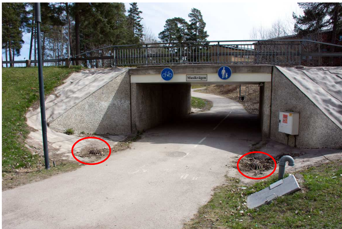
Figur 6. Dagvattenbrunnar markerade vid tunneln under Musikvägen.
