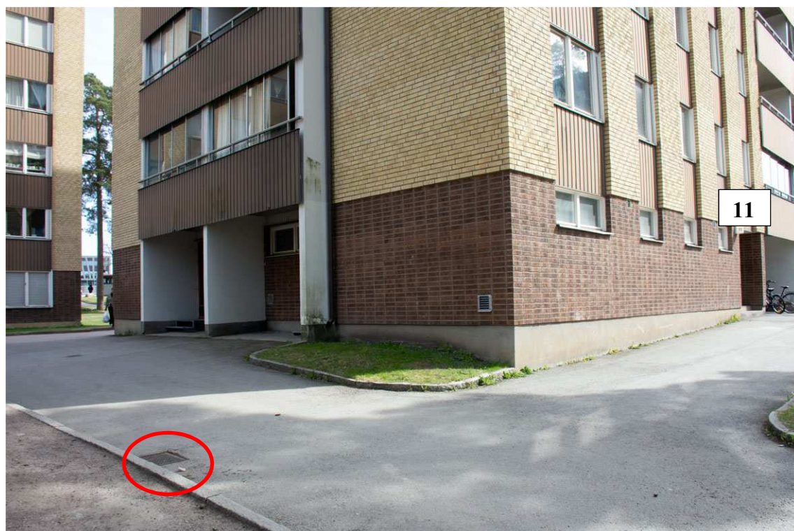
Figur 4. Dagvattenbrunn markerad vid kortsidan av byggnaden till Blomdahls väg nr 11.
