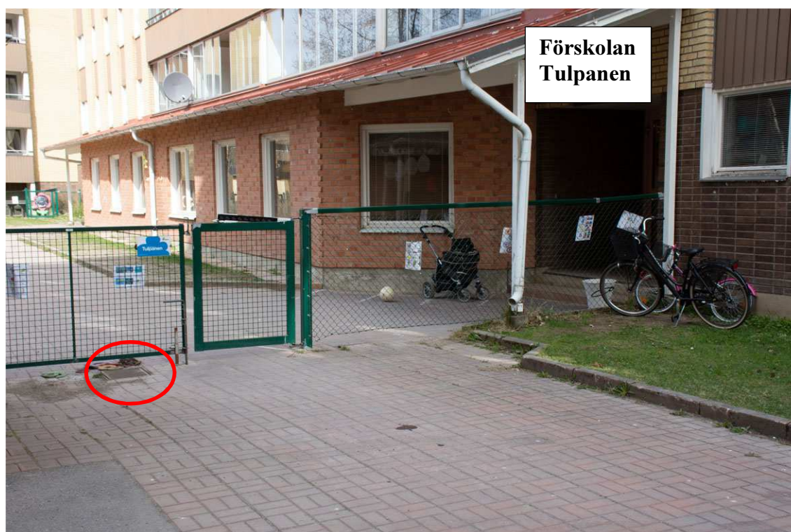
Figur 3. Dagvattenbrunn markerad vid grinden till Förskolan Tulpanen på baksidan av Blomdahls väg 9.
