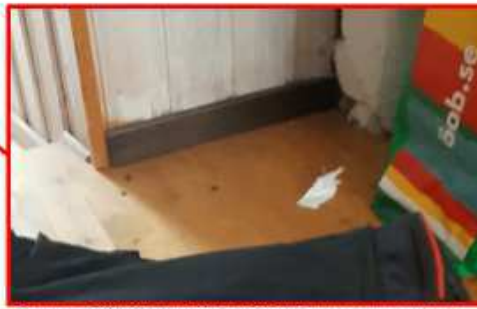
Förstoring av 70201451-38ea-48a5-97b1-aed8d20e587be.webp som visar detaljer på vägg och murstock.
