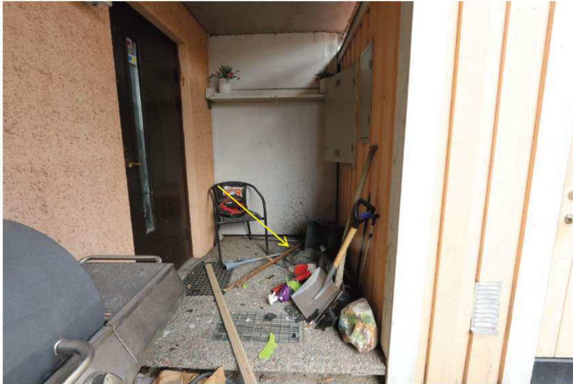
Figur 4. Utanför ytterdörren. Splitterskador på väggar och ytterdörren synliga. Gul pil markerar krevadgropen.
