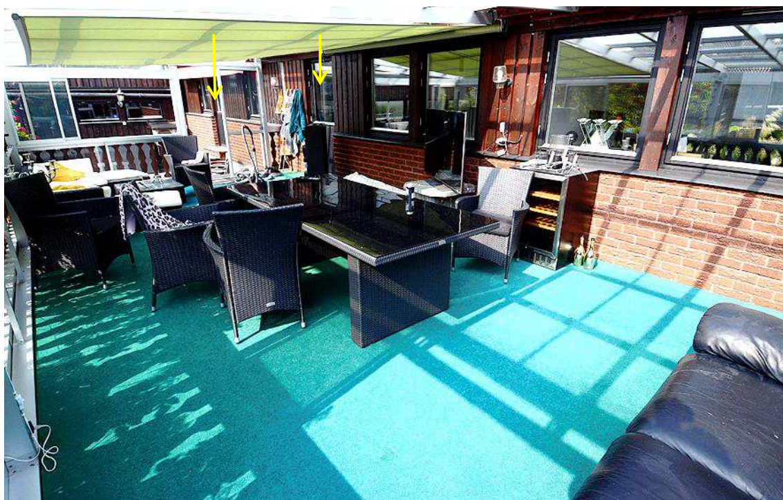
Figur 9. Uterummet fotograferat från inre delen. Altandörren in till köket och skjutdörren ut mot altandäcket är markerade
