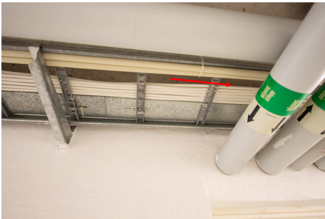
Figur 4. Kabelstegen. Pilen markerar var spår S027 säkrades.
