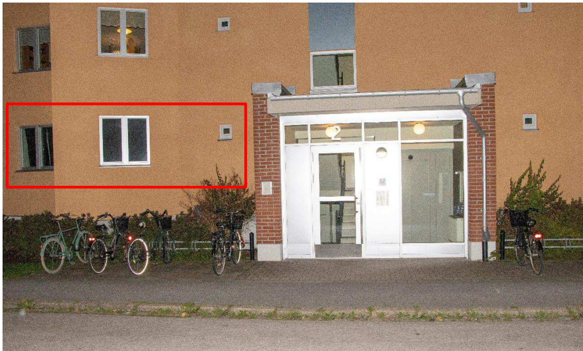
Figur 3. Entrén till Kastanjegatan 2. Aktuell lägenhets fönster som vetter ut mot gatan är markerade med en röd rektangel.
