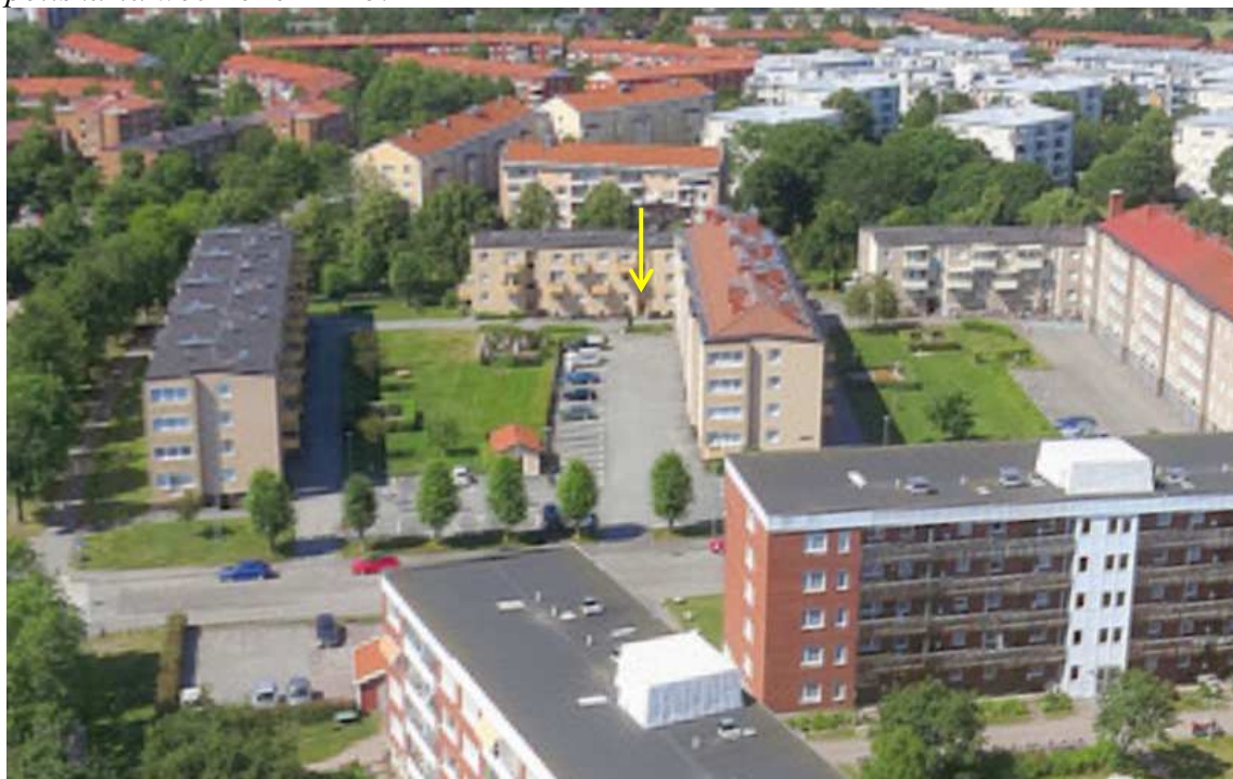
Figur 2. Drönarfoto över aktuell plats. Entrén Murargatan 16 B är markerad.
