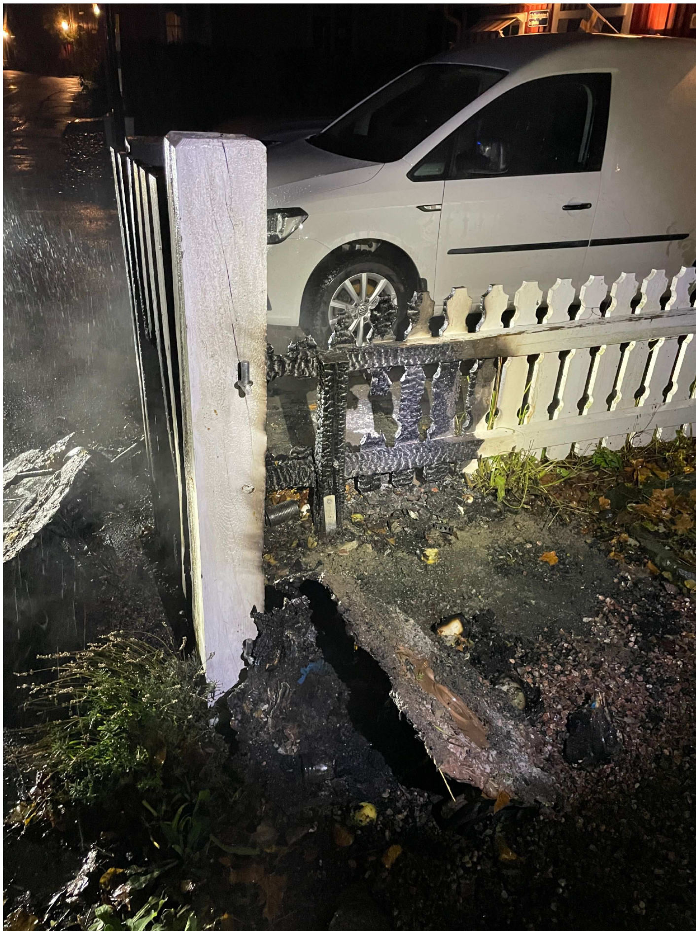
6. Bild föreställande två nedbrunna soptunnor samt ett brandskadat staket. /Pa Spegel- Nääs
