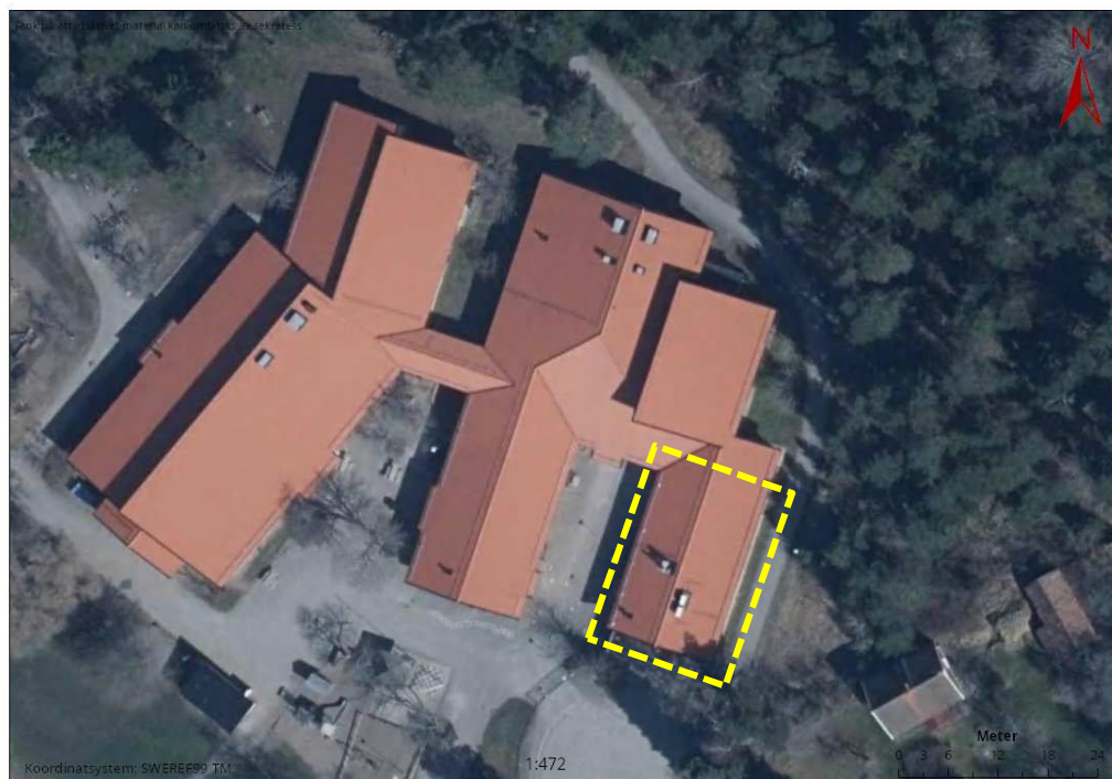
Figur 2. Satellitbild över Kristinelundsskolan i Östhammar, där den brandskadade delen av byggnaden är markerad. (Källa: Poliskarta Web 2023-12-07.)
