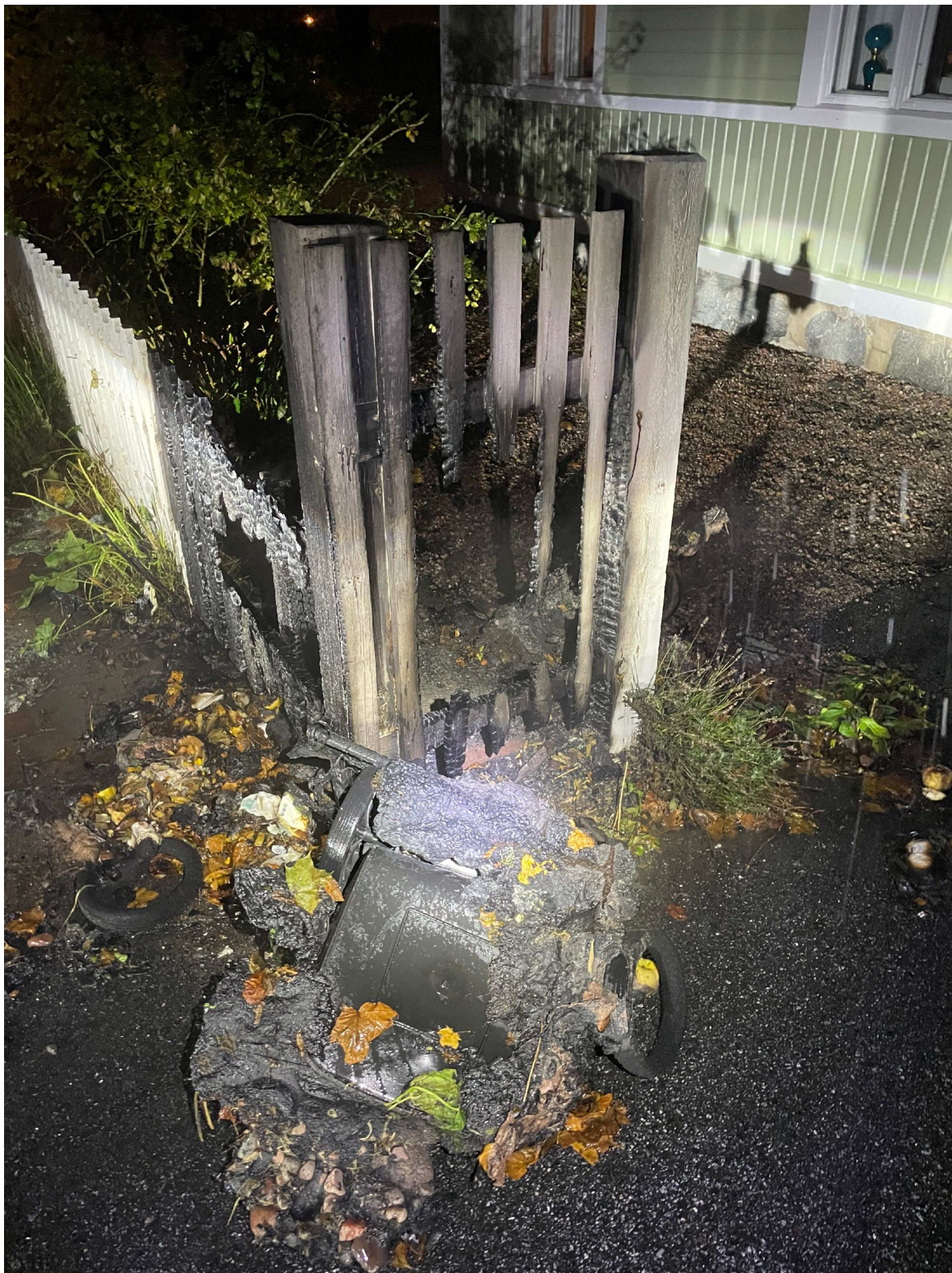
9. Bild föreställande två nedbrunna soptunnor samt ett brandskadat staket. /Pa Spegel- Nääs
