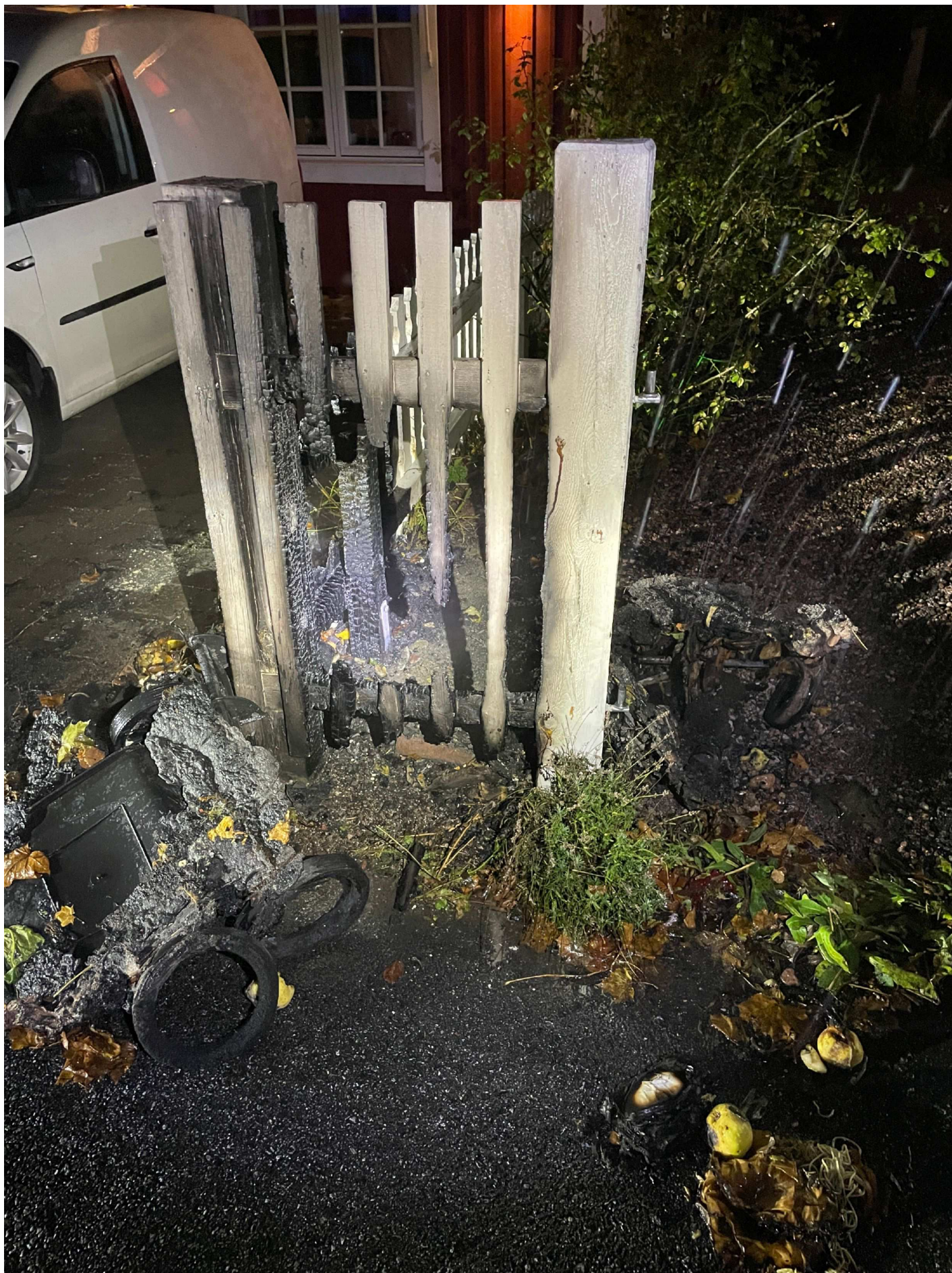
8. Bild föreställande två nedbrunna soptunnor samt ett brandskadat staket. /Pa Spegel- Nääs
