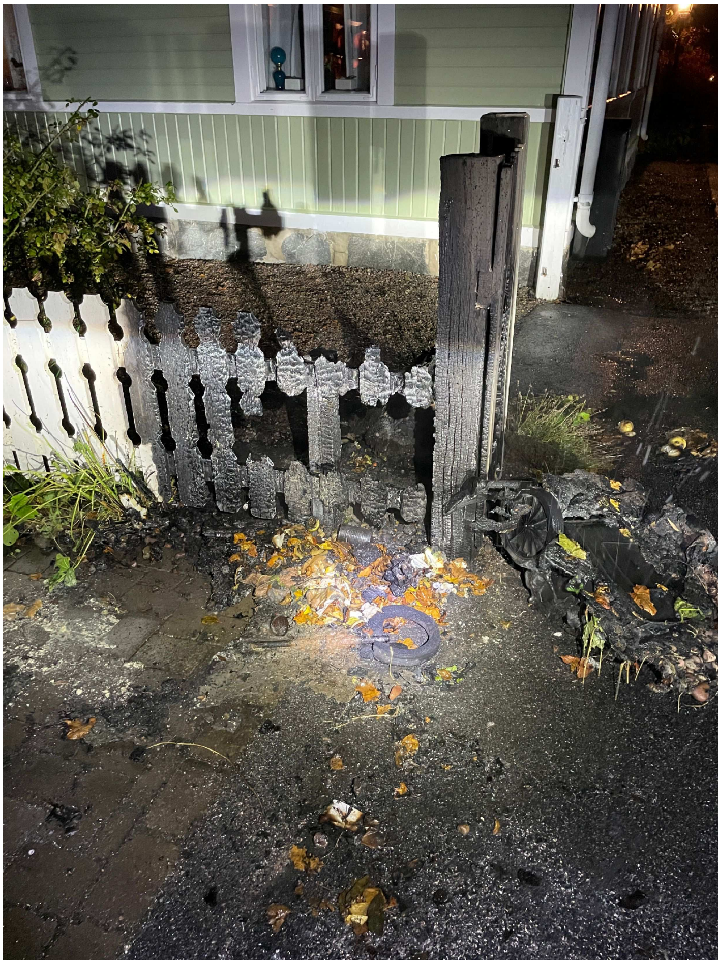
10. Bild föreställande två nedbrunna soptunnor samt ett brandskadat staket. /Pa Spegel- Nääs
