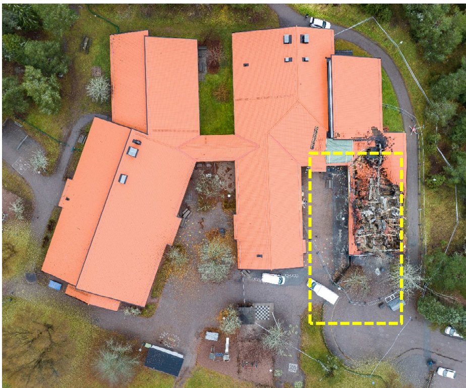
Figur 3. UAS-foto över skolbyggnaden, där den skadade delen av byggnaden är markerad.
