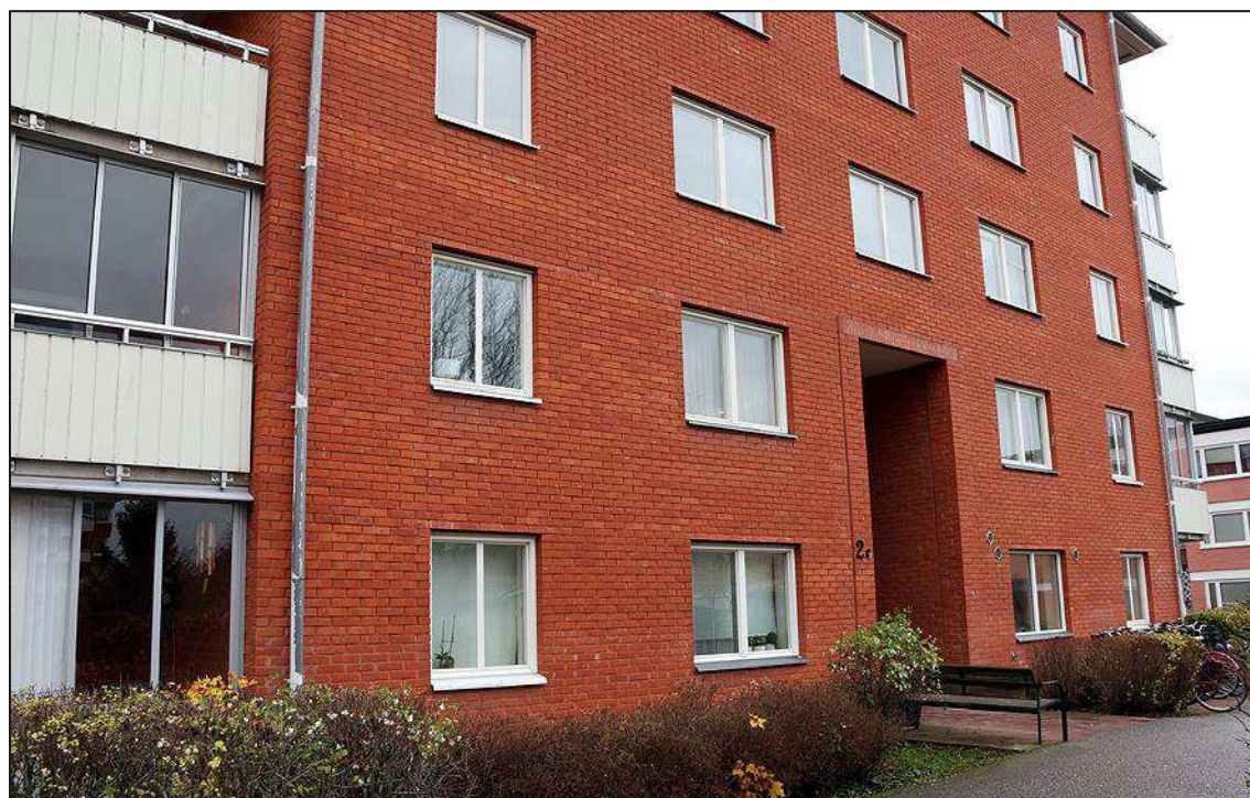
Figur 2. Albert Engströmsgatan 2G i Uppsala fotat i sydöstlig riktning.
