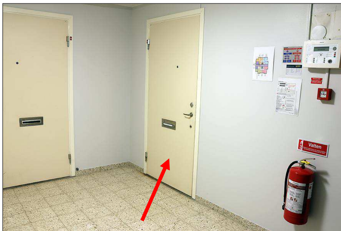
Figur 4. En del av fjärde våningsplanet där ytterdörren till aktuell lägenhet är markerad.
