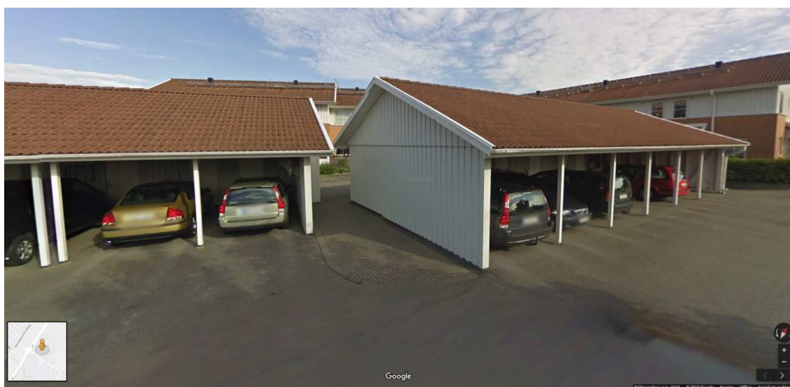
Figur 2. Den aktuella nerbrunna carporten är den till höger i bilden. Bilden är hämtad från google.se den 24 juni 2019.
