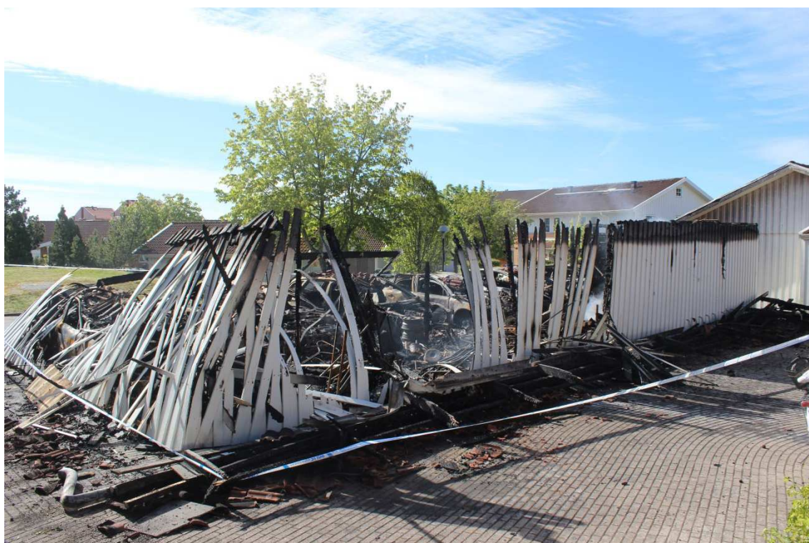
Figur 6. Carporten, norra och västra sidan.
