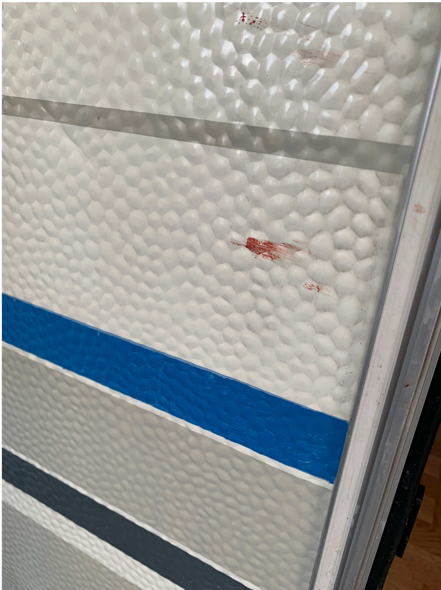
19. Foto av yttervägg vid husvagnsdörr. Foto taget av PA Kämpe Gunnarsson.
