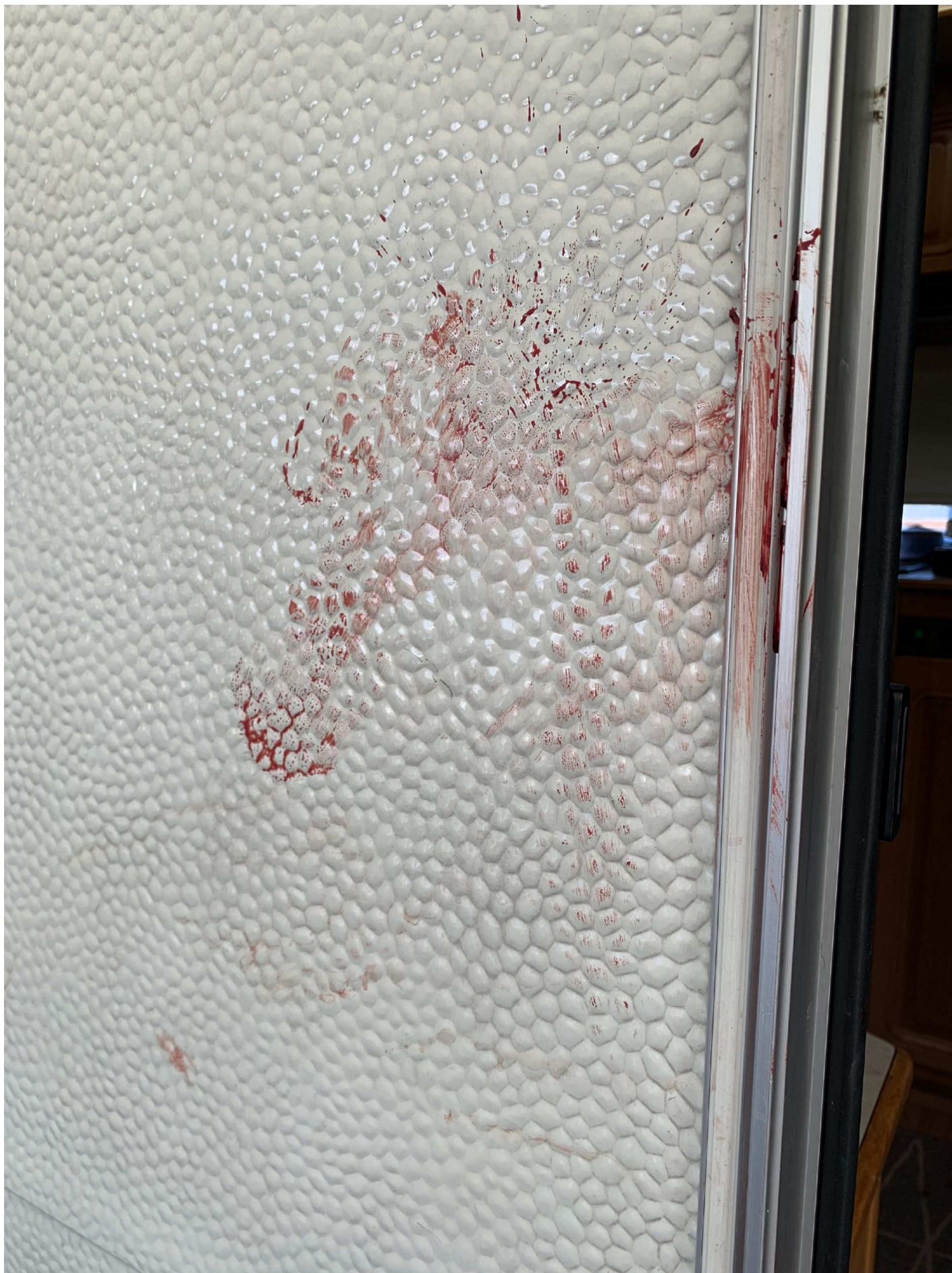
21. Foto av yttervägg vid husvagnsdörr. Foto taget av PA Kämpe Gunnarsson.
