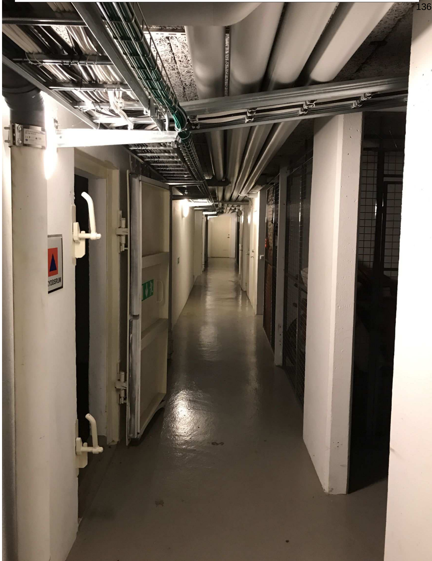
14. Korridor på andra sidan dörr från bild 12 och 13
