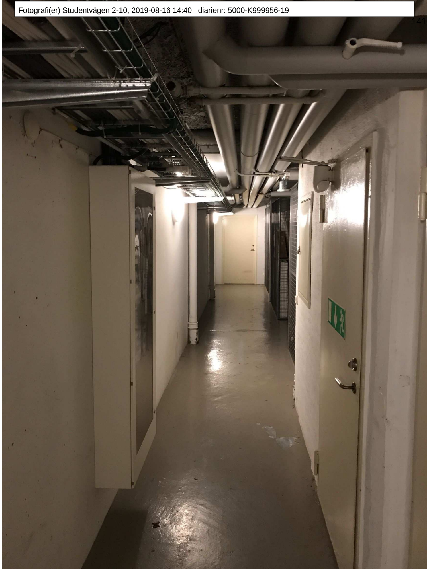
19. Korridor sedd från barnvagnsförråd, Studentv. 6
