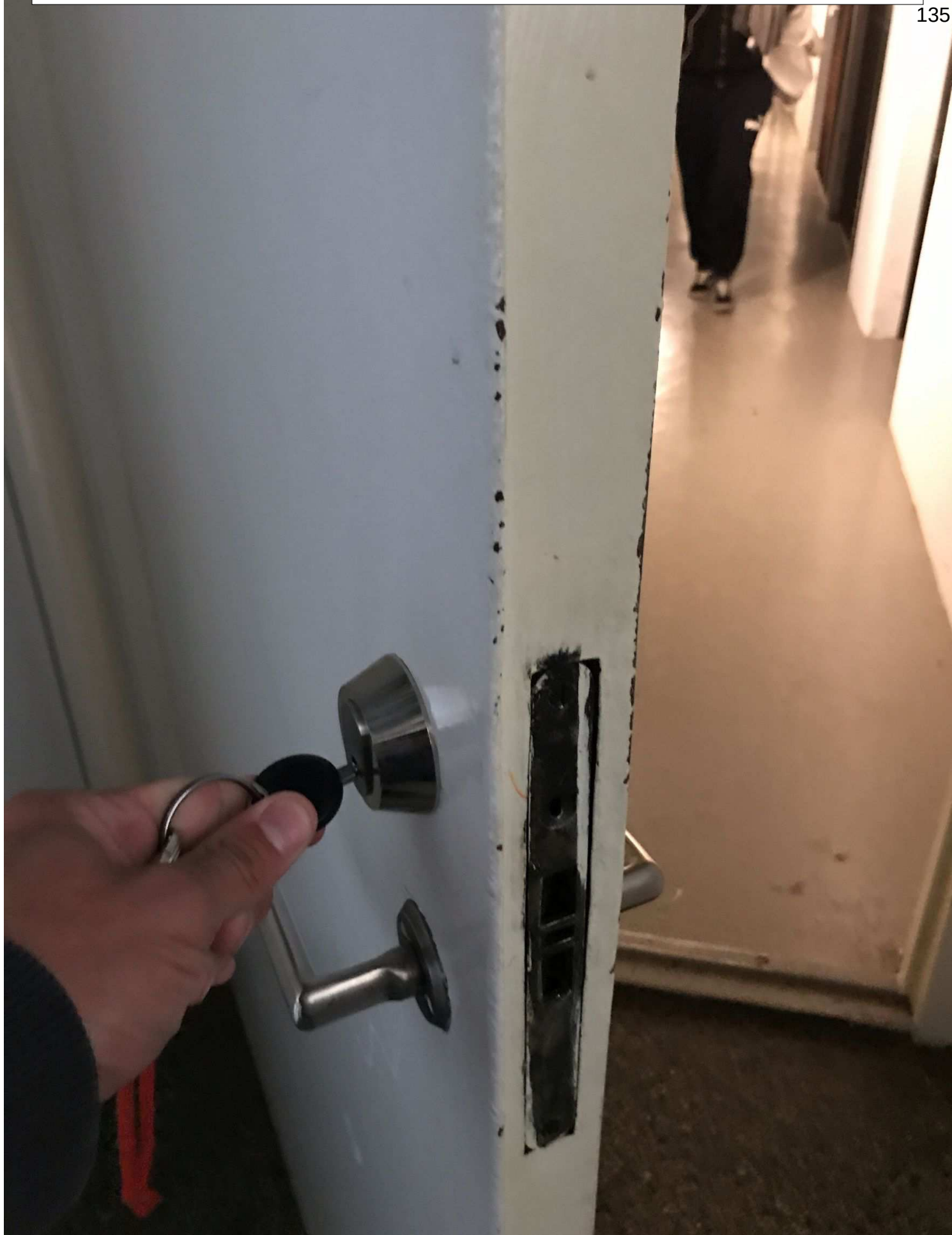
13. Dörr som syns på bild 11 öppnas med iLOQ S6115
