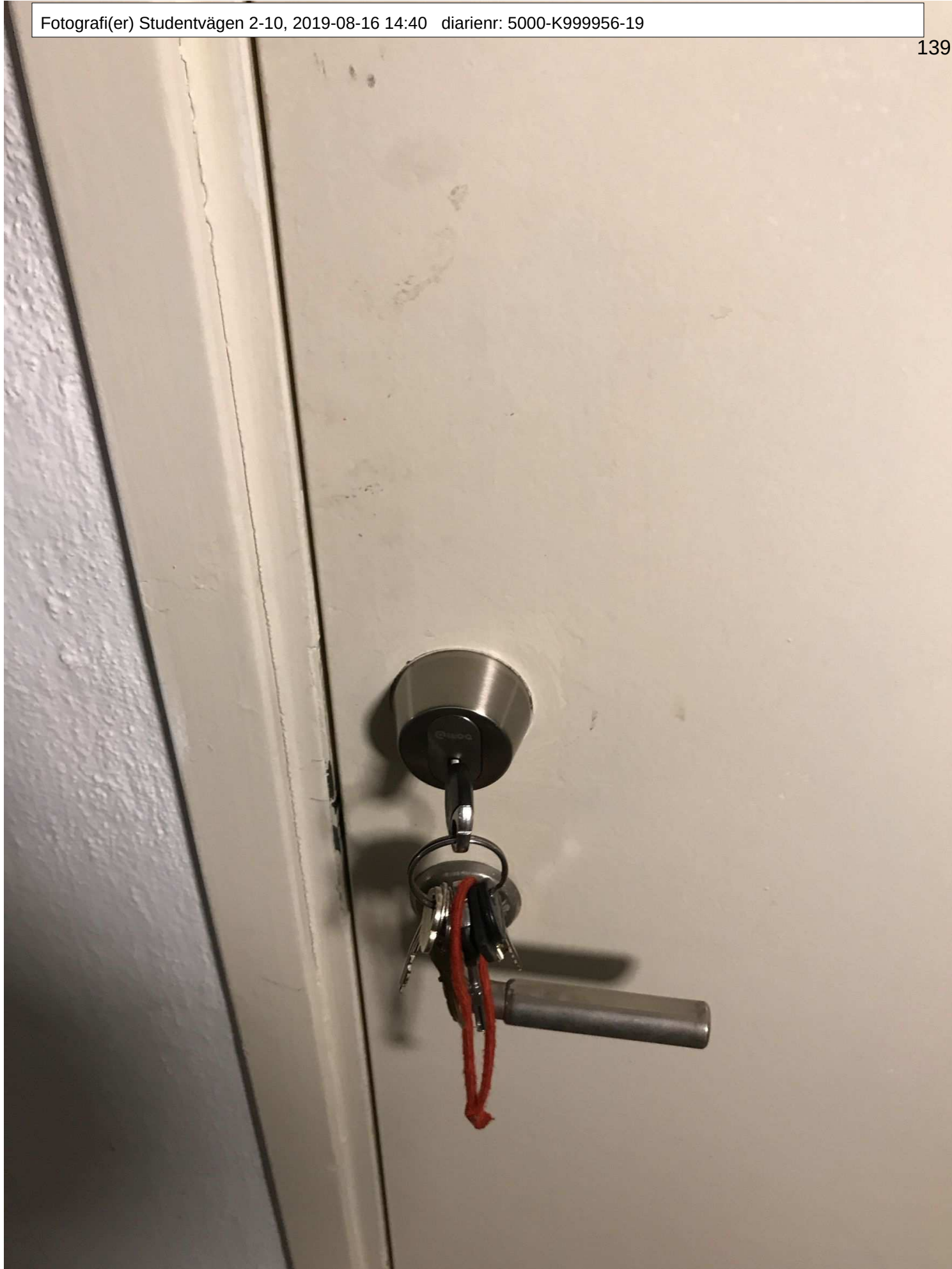
17. Dörr till barnvagnsförråd, Studentv. 6. Öppnas med iLOQ S6115
