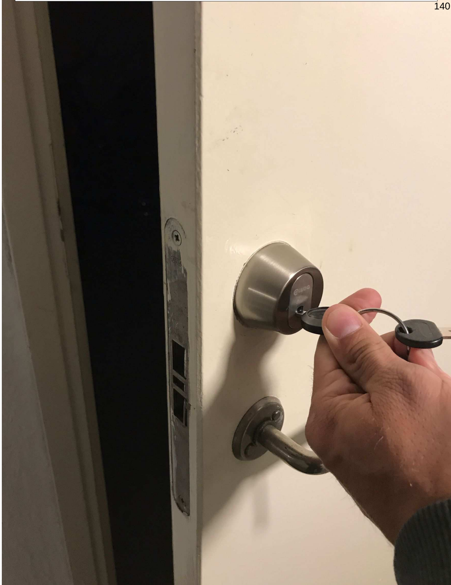
18. Dörr till barnvagnsförråd, Studentv. 6. Öppnas med iLOQ S6115
