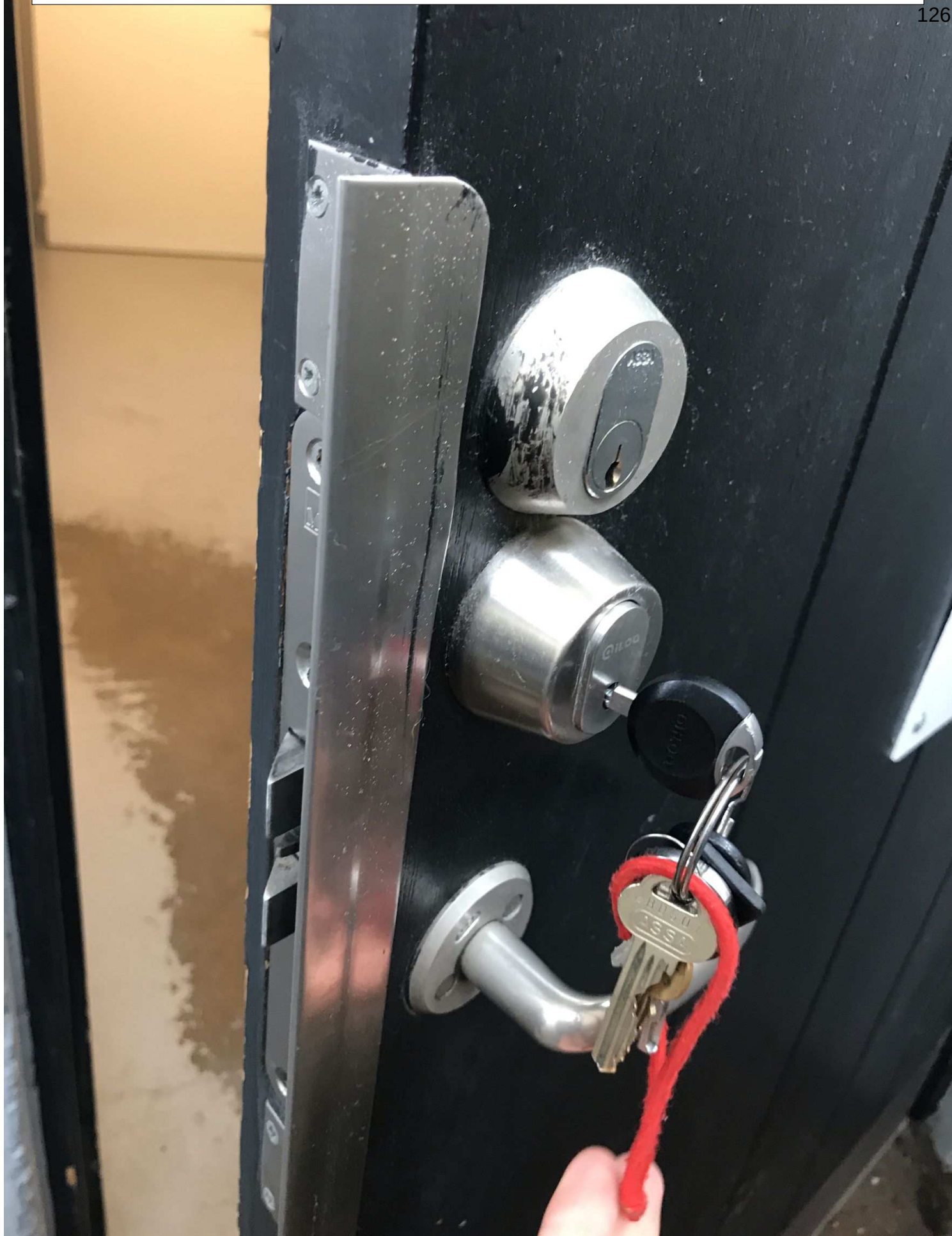
4. Ytterdörr till källare, Studentv 2-10. Öppnas med Getoarbs nyckel iLOQ S6115
