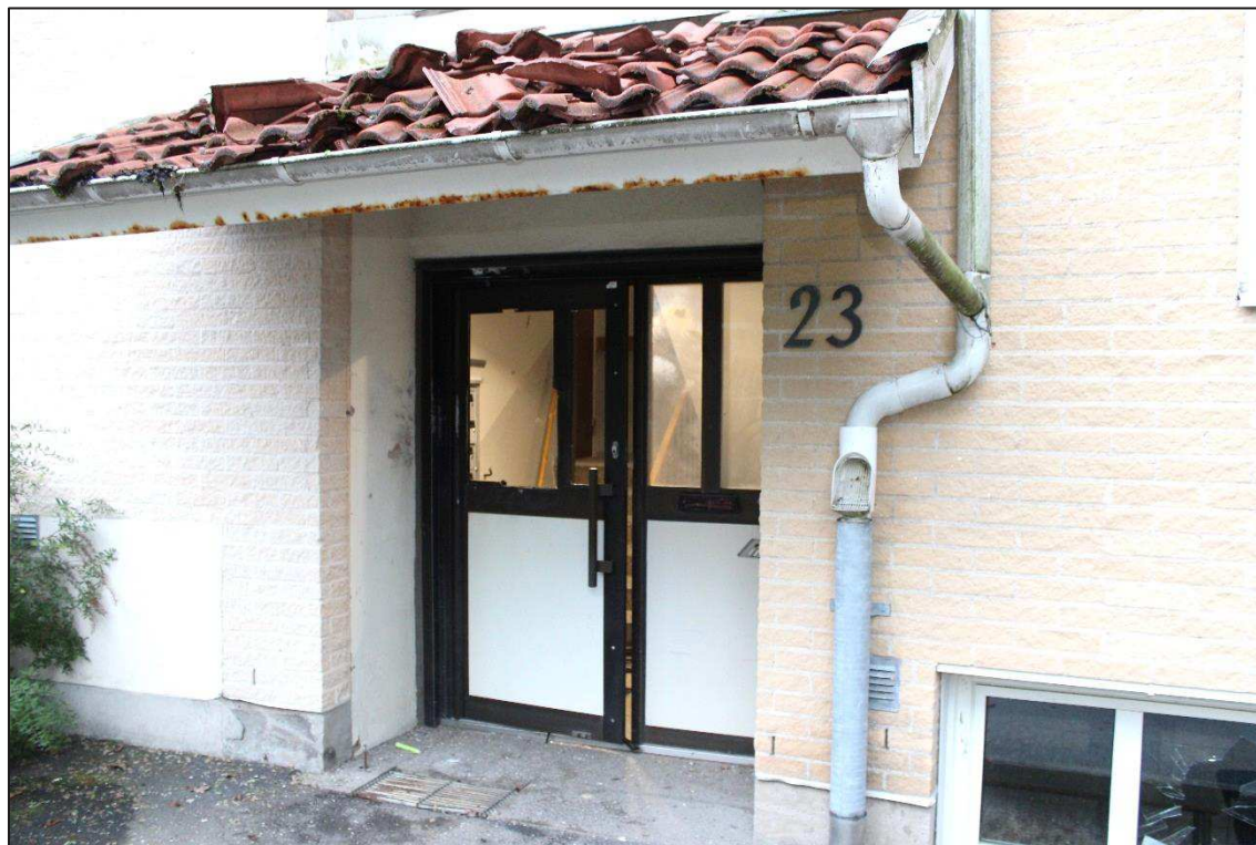
Figur 6. Entrédörren till trapphuset.
