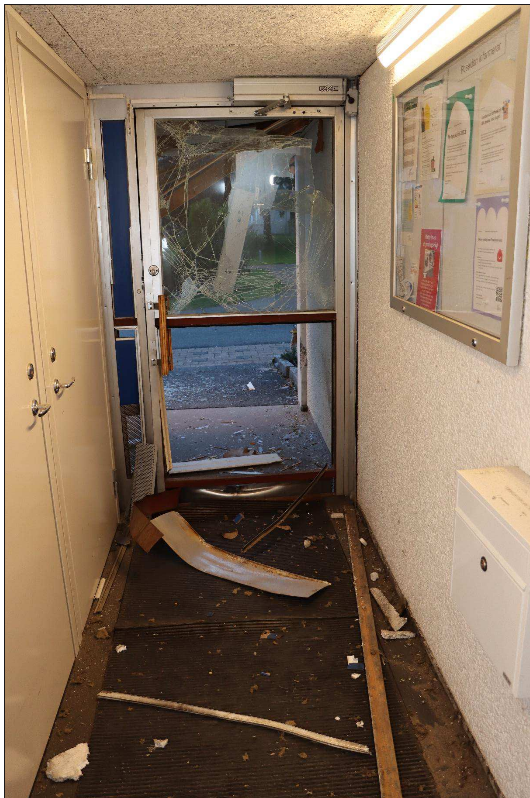
Figur 15. Entrén sett från trapphuset.
