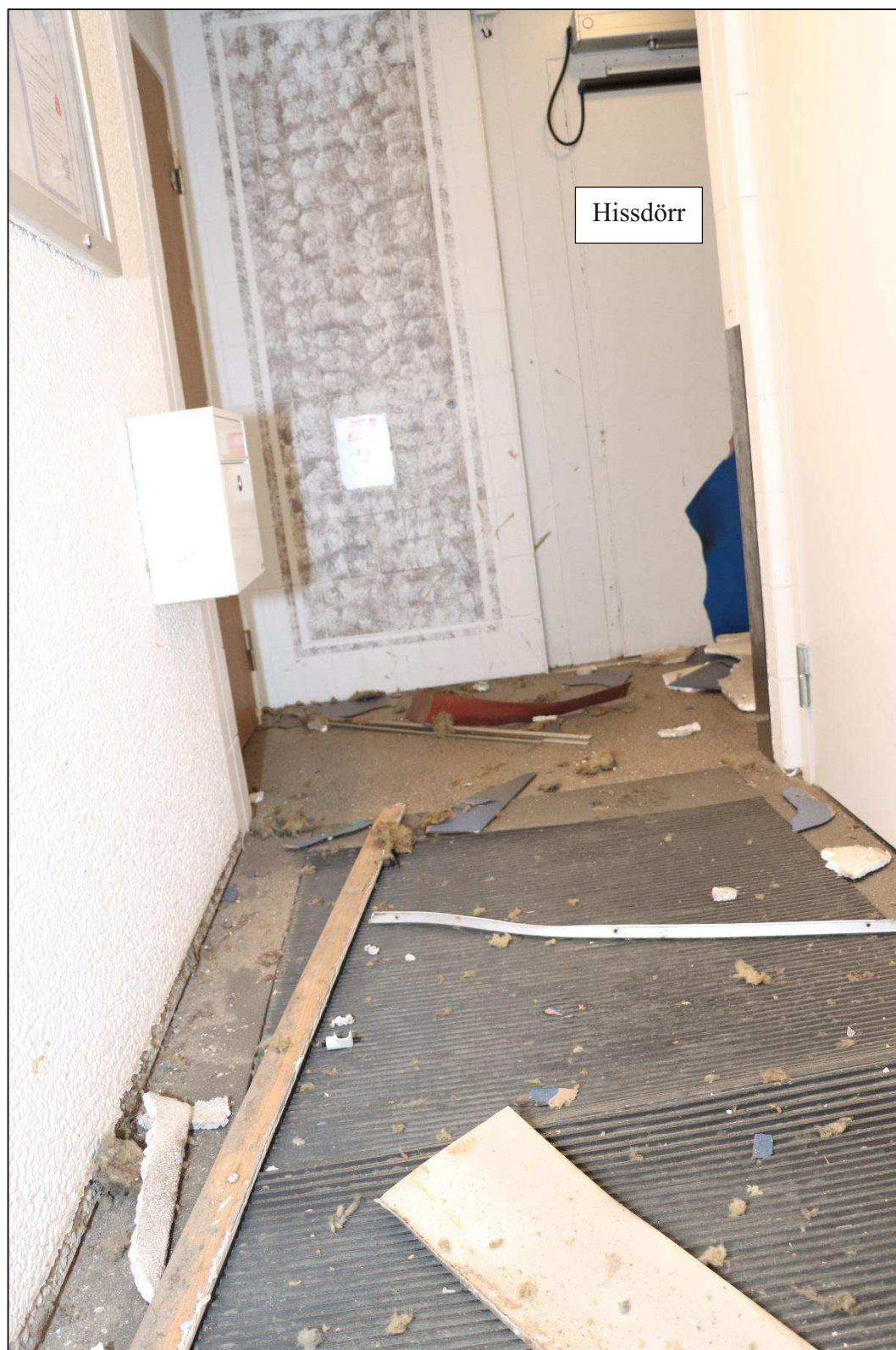
Figur 16. Trapphuset sett från entrédörren. Hissdörren är markerad i bilden.
