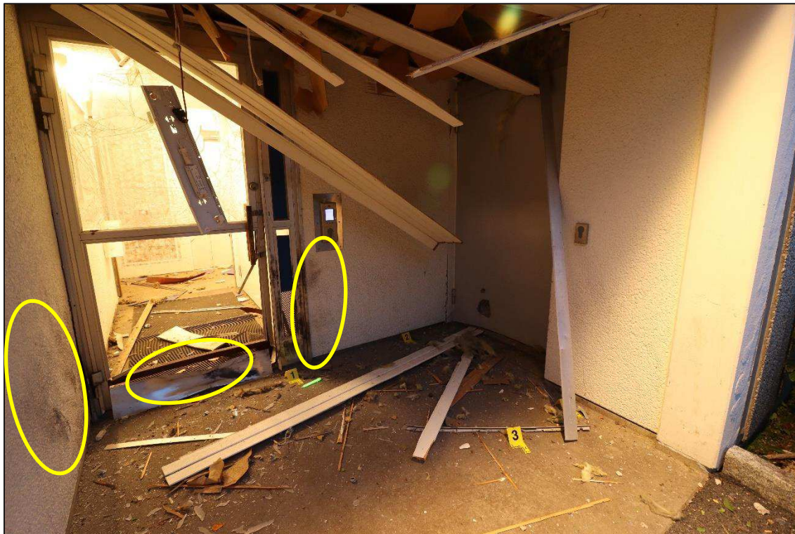
Figur 9. Entréprånget. Gula markeringsskyltar markerar metallsplitter. Den gröna ljusstaven har placerats av NBS för att markera metallsplitter. Ytor för avtork(S002-S004) är markerade i bilden.
