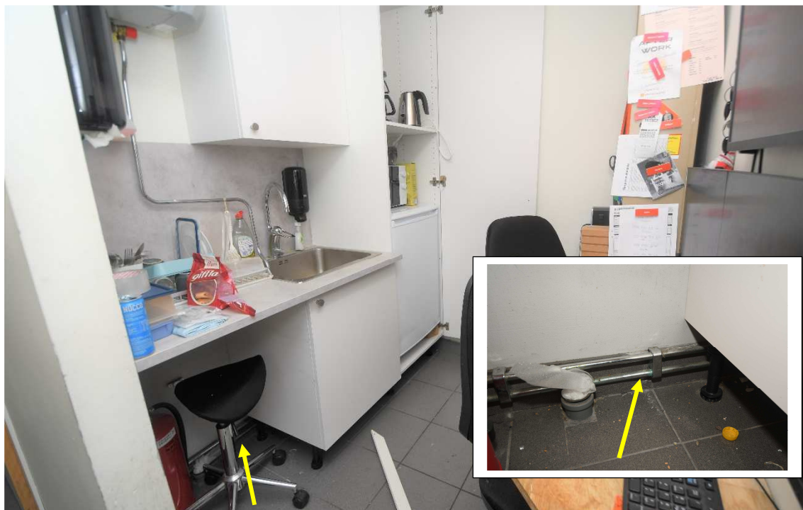
Bild 20 Kontor med pentry. Toalett till vänster utanför bild. Pilen visar mot slagsmärket (se även infälld bild).
