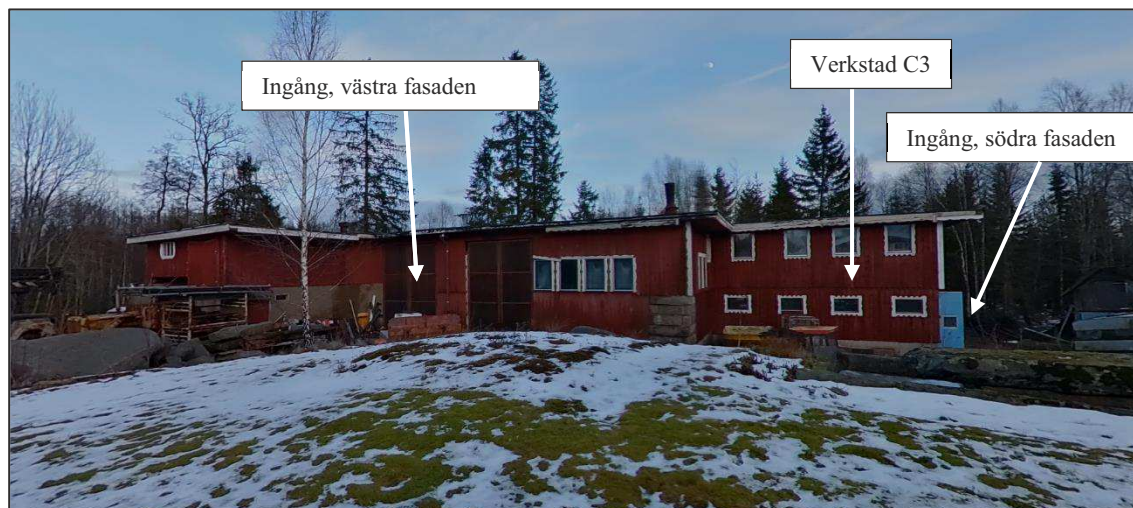
Figur 41. Maskinhallen, västra ingången och södra ingången. Södra ingången ledde till verkstaden (C3).
