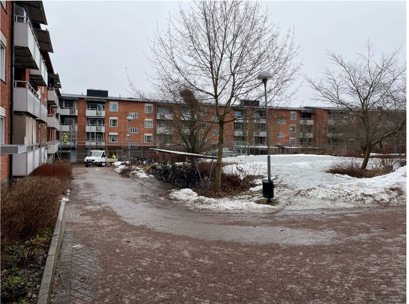
8. Bild tagen av Insp Karis Angbrant 2024-02-29. Innergården Gruvgången 9-13. Fastigheten sett till vänster i bild är Gruvgången 1-9.
