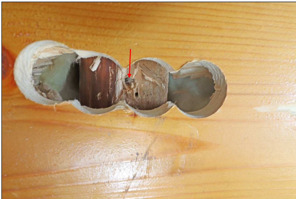
Figur 18. Röd pil markerar hålet i träregeln.
