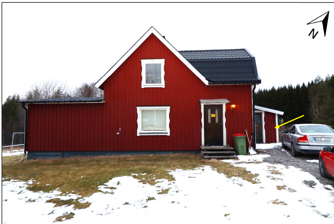
Figur 3. Översiktsbild över husets framsida. Gul pil markerar det vidbyggda förrådet.
