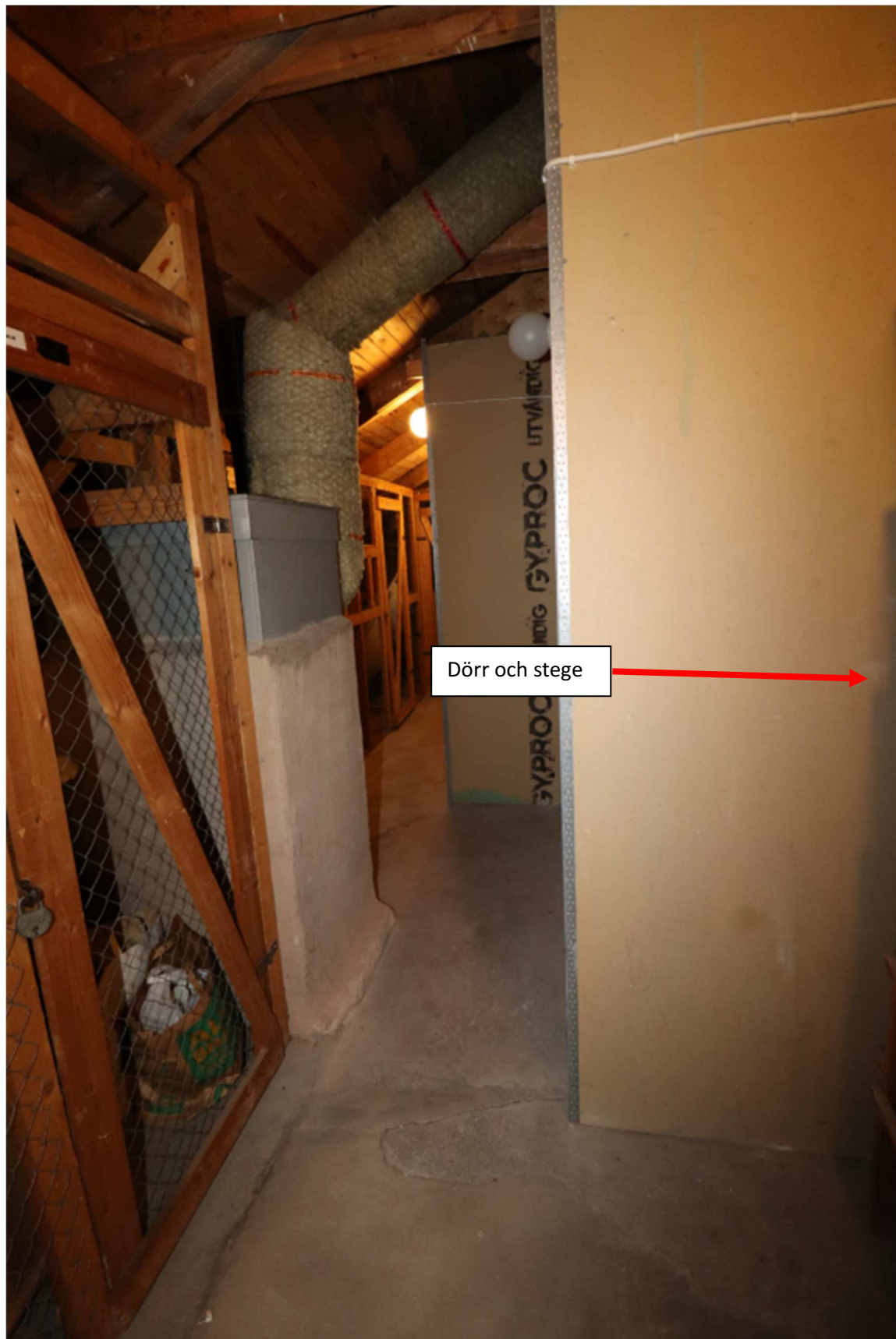
Bild i riktning höger i utrymme 1
