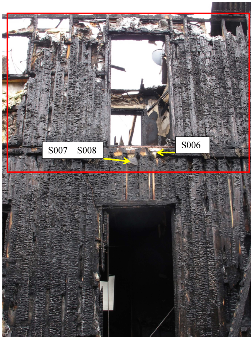
Bild 7. Brandprov 5701/31028-15/S006, bärlina trapp utanför entrédörr och 5701/31028-15/S007 - 5701/31028-15/S008 brädfodring under tröskel, utsida entrédörr
