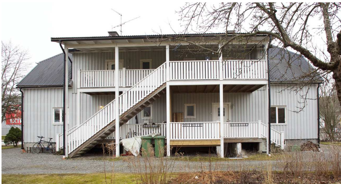
Bild 4. Norra sidan av aktuell fastighet innan den eldhärjades. Bilden visar den bortbrända trappen. Källa: Svensk Fastighetsförmedling.
