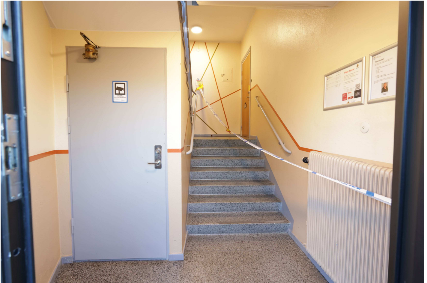
1. Taserudsgatan 9a, Arvika (sett från husets entré) källardörr till vä och mt:s lägenhetsdörr till hö i bild.
