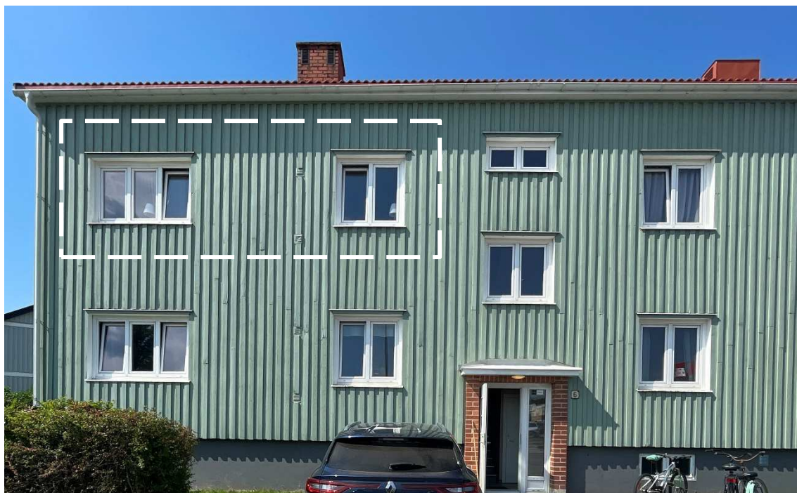
Figur 3. Lägenheten 1201. Vit streckad linje visar lägenhetens fönster på östra sidan av byggnaden.
