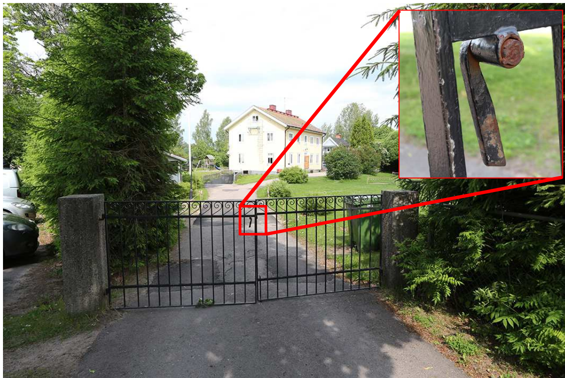
Figur 7. Södra grinden. En järngrind där grindklinkan var av på insidan och brottytan på klinkan var rostangripen. Grinden öppnades inåt utan kraftansträngning. Infälld bild i övre högra hörnet visar den trasiga klinkan.
