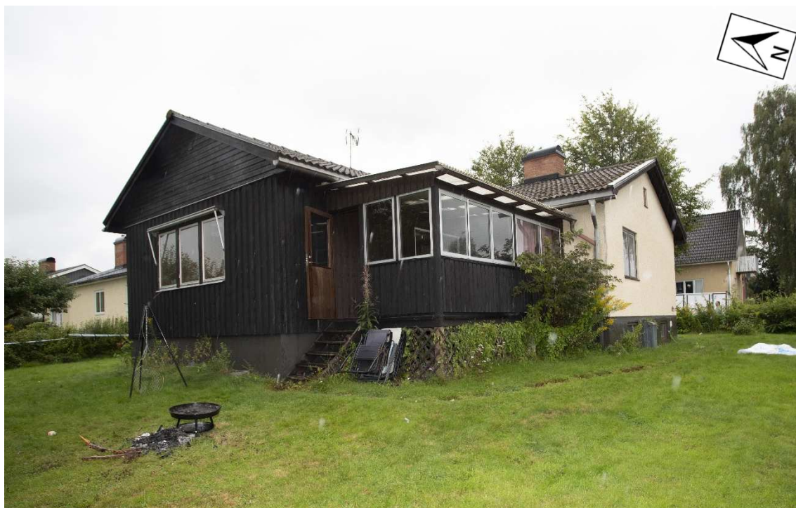
Figur 4. Översiktsbild på husets västra och södra sida.
