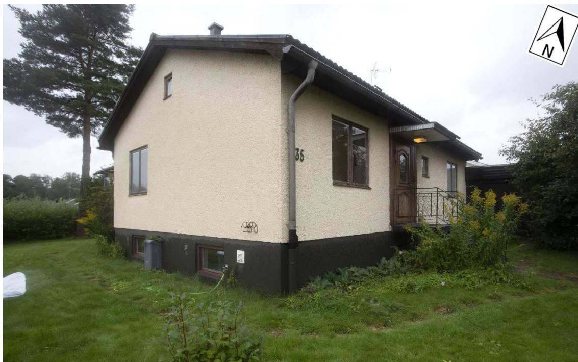
Figur 3. Översiktsbild på husets södra och östra sida med entrédörren till höger i bilden.
