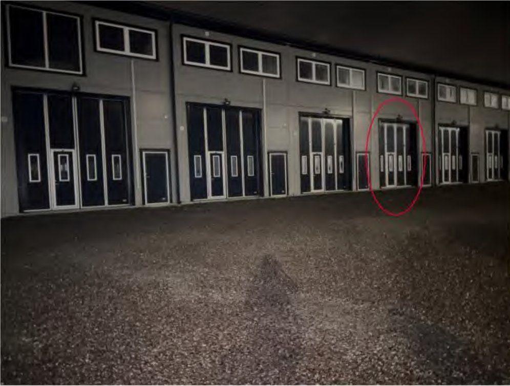
Bild med port 4 markerad på Hornvägen 11, Bålsta.
