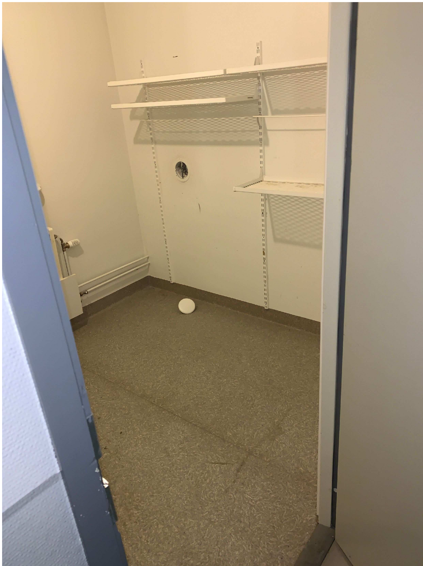
1. Översiktsbild på ventilhålet inne i rummet som ventilen från barnvagnsrummet leder in till.
