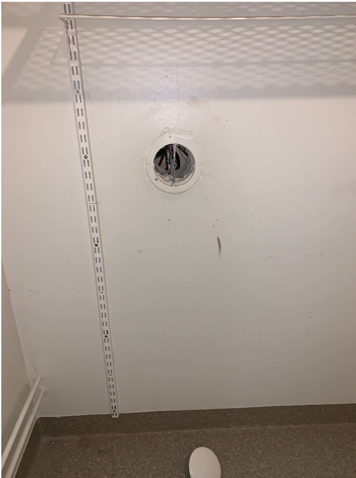
2. Översiktsbild på ventilhålet inne i rummet som ventilen från barnvagnsrummet leder in till.
